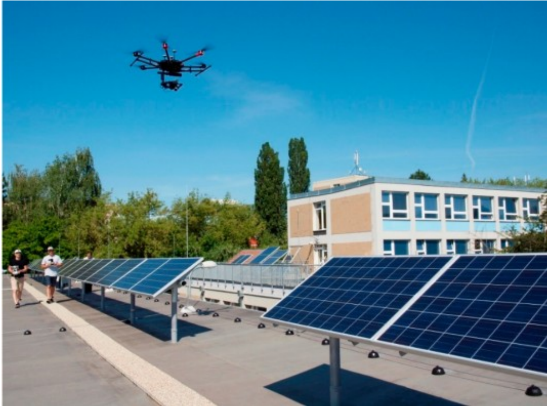
Obr. 29: Fotovoltaická elektrárna na střeše technické fakulty s monitorujícím dronem Zdroj: (Libra et al., 2019)
