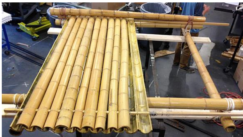
Obr. 12 Příklad pokládky střešní krytiny (Pixwood 2014)
