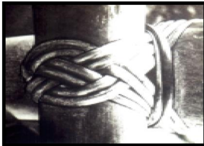
Obr. 6 Svazovaný spoj ratanovými pásky (Dunkelberg 1985)
