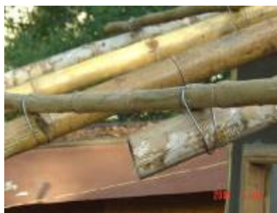
Obr. 11 Praktický příklad přivazování střešních latí (Paudel, Aye 2003)
