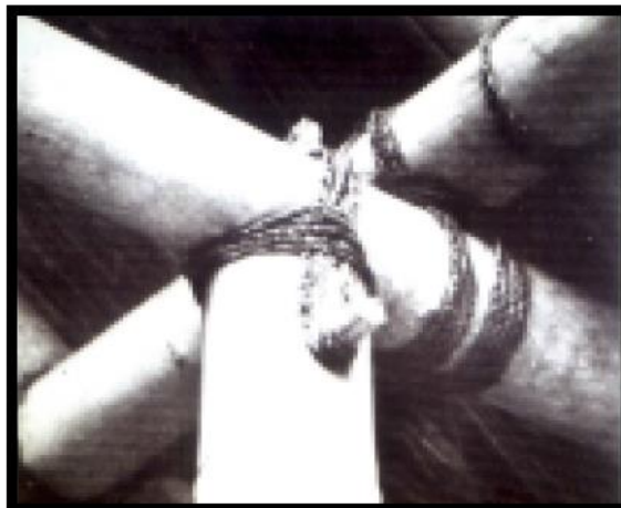
Obr. 8 Spojení čepem pojištěného svázáním (Dunkelberg 1985)
