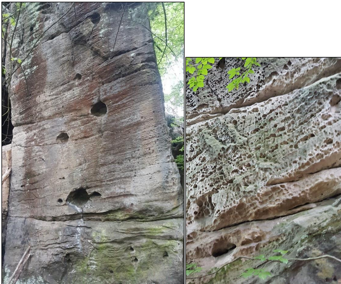
Obrázek 15 – šestá stěna s voštinami 50.5181925N, 15.2022592E (foto J. Chlupáč, 2021)
