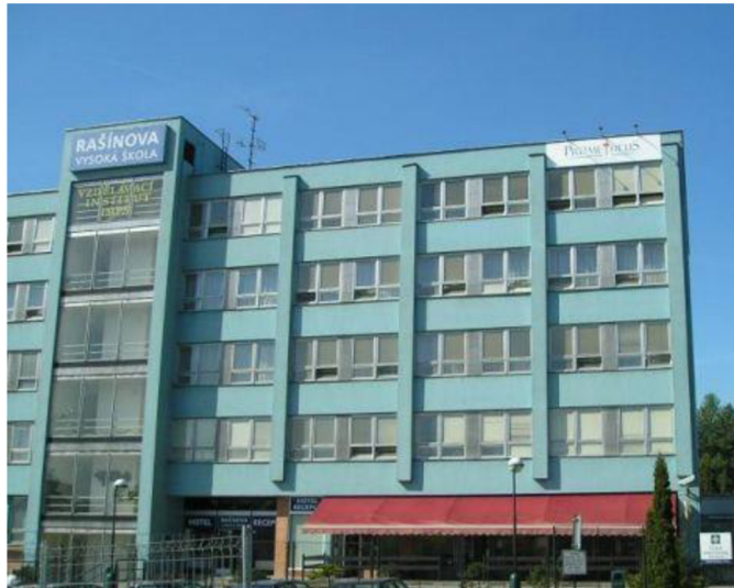
Obrázek č.1: Fotografie budovy hotelu Prometheus dříve (zdroje hotelu)
