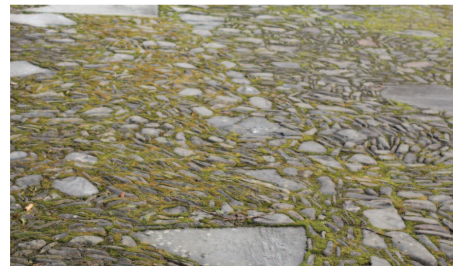
Obr. č. 87. / Kamenná dlažba.
