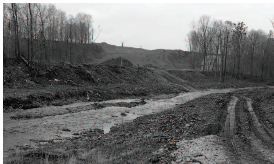
Obr. č. 76. / Pohled na staveniště přeložky mezinárodní silnice.
