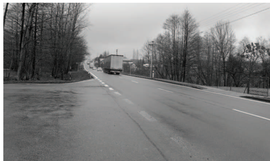
Obr. č. 75. / Pohled na stávající mezinárodní silnici.
