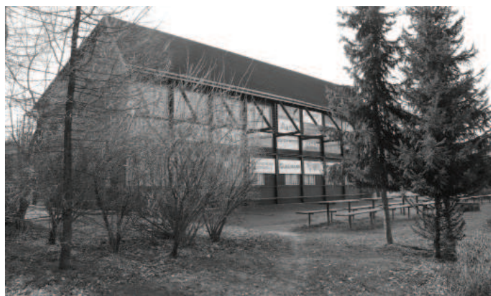
Obr. č. 127. / Na hřišti, pohled na budovu zázemí, stávající podoba.
