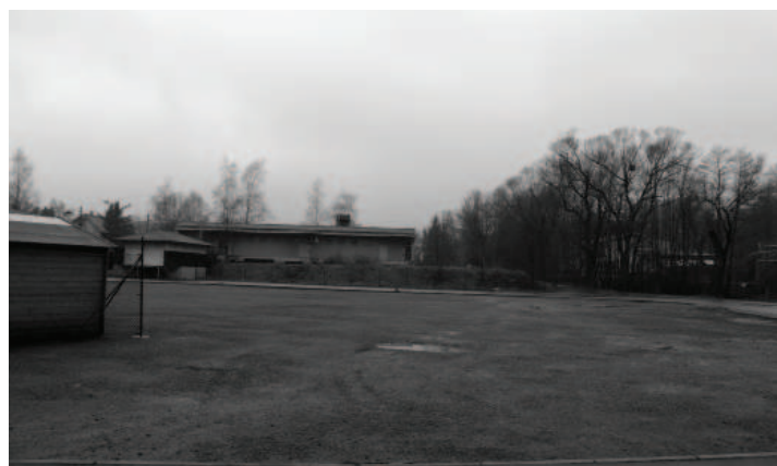
Obr. č. 118. / Na Tyrské, pohled na samoobsluhu, stávající podoba.
