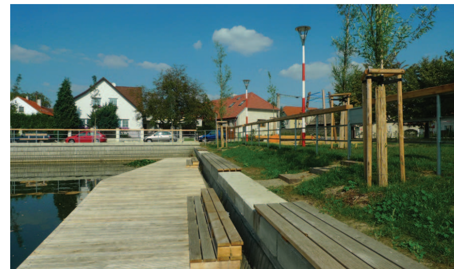
Obr. č. 26. / Realizace revitalizace návsi v Braškově z roku 2009.
