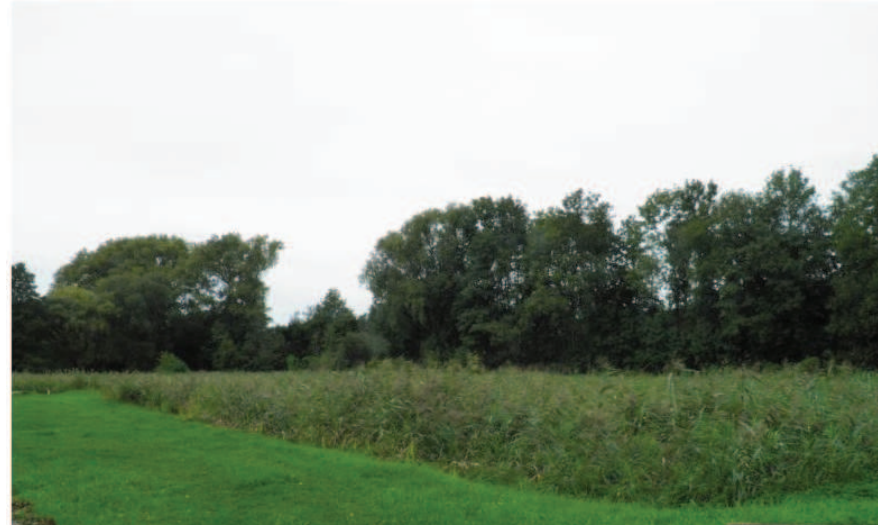
Obr. č. 6. / Kořenová čistírna odpadních vod ve Spáleném Poříčí
