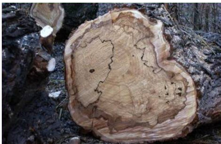
Obr. č. 1 Hniloba bílá způsobená ohňovcem obecným ( Phellinus igniarius ) dostupné z: ( http://www.stromvemeste.cz/choroby_skudci/bila_hniloba/bila_hniloba.html ).
