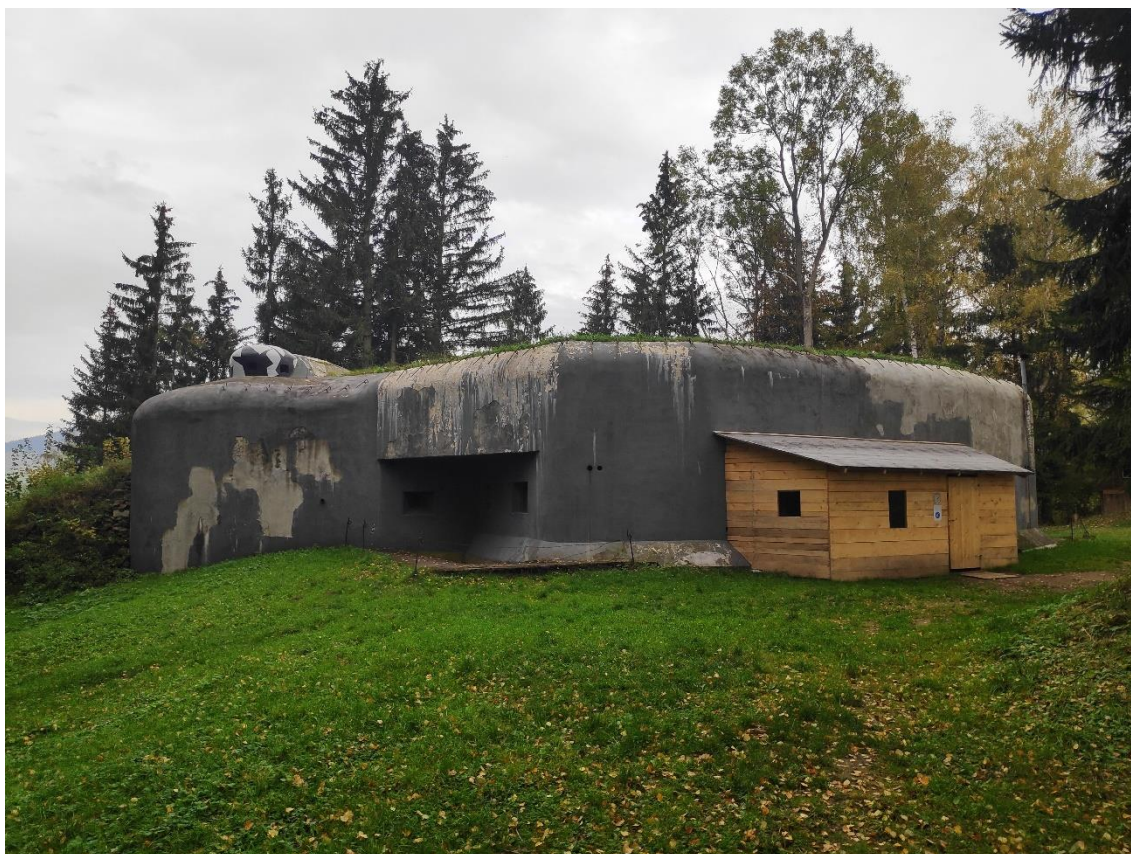
Obr. 7: K-S 5 s dřevěnou budkou před vchodem do objektu v současnosti.
