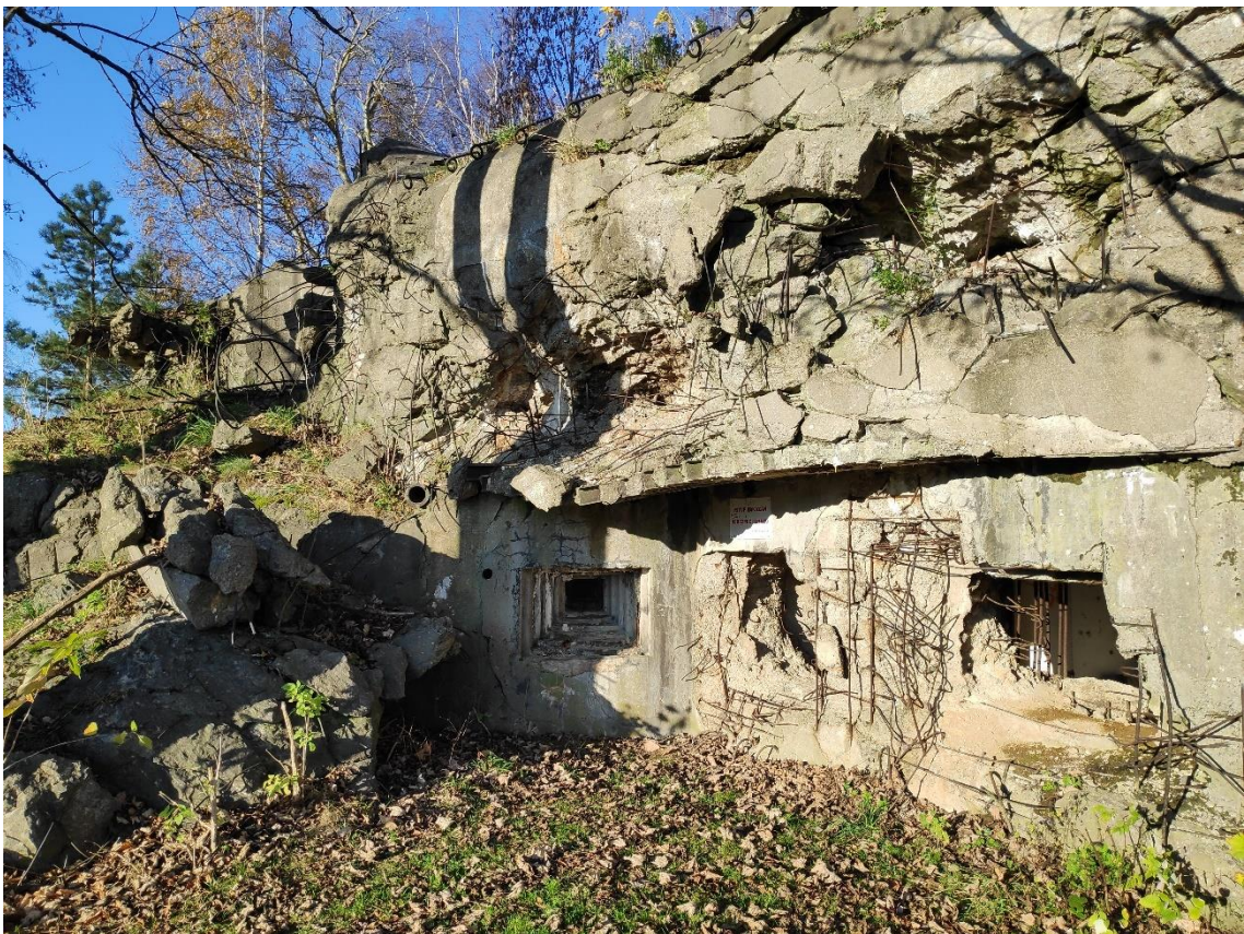
Obr. 27: Střelecká místnost K-S 18 s vytrženými střílnami, které umožňují vstup.
