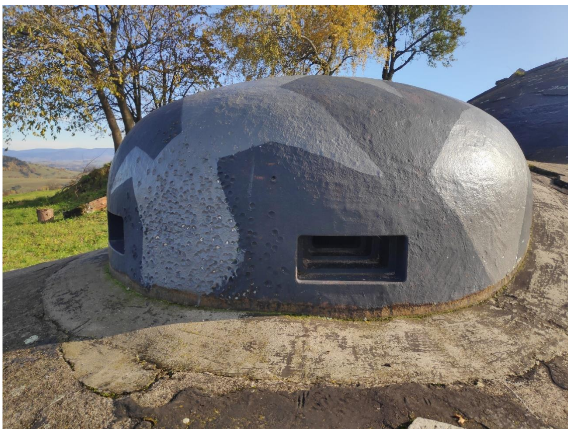
Obr. 19: Poškození pozorovacího zvonu K-Bg S12b palbou pěchotních zbraní. Zdroj: Zeman, F. (2020), fotografie pořízena autorem práce.
