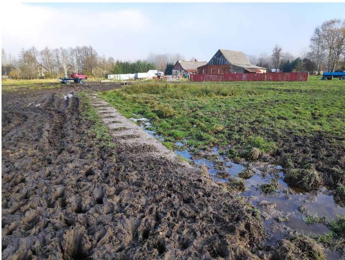
Obr. 50: Železobetonový práh, intervalová překážka mezi K-S 18 a K-S 19 procházející rozbahněnou pastvinou.
