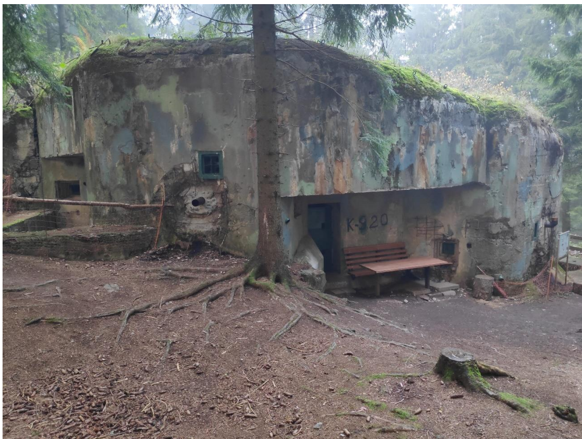
Obr. 29: Pozůstatky maskovacího nátěru a oplocené diamantové příkopy u K-S 20. Zdroj: Zeman, F. (2020), fotografie pořízena autorem práce.
