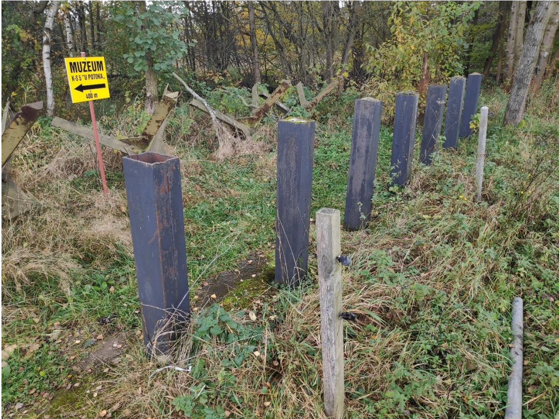
Obr. 40: Dochované ocelové jehly v intervalové překážce mezi K-S 5 a K-S 6.
