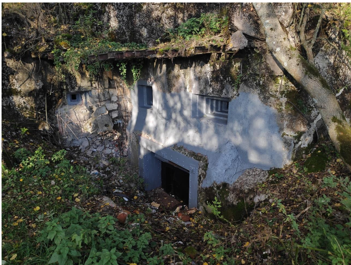
Obr. 10: Kolejnice sloužící jako výztuže stropu střelecké místnosti nad minometnou střílnou, viditelné zvenčí, K-S 7.
