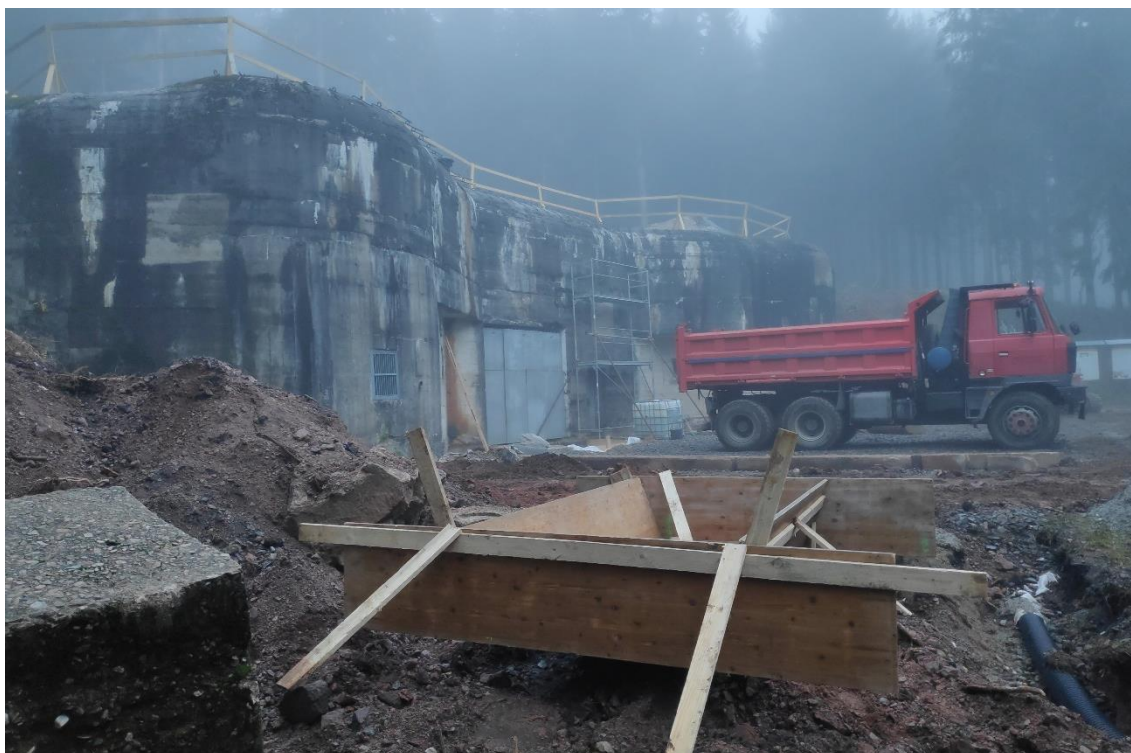
Obr. 32: Rozsáhlá rekonstrukce vchodového objektu K-Ba-S 22a v době pandemie. Zdroj: Zeman, F. (2020), fotografie pořízena autorem práce.
