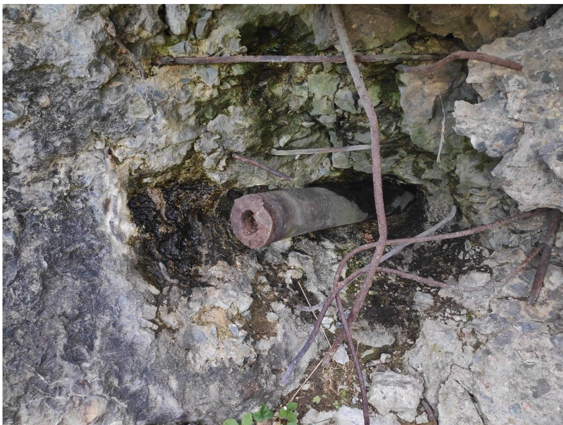
Obr. 15: Pozůstatky německé střely „Röchling“ v ochranném křídle K-Bg-S 11.
