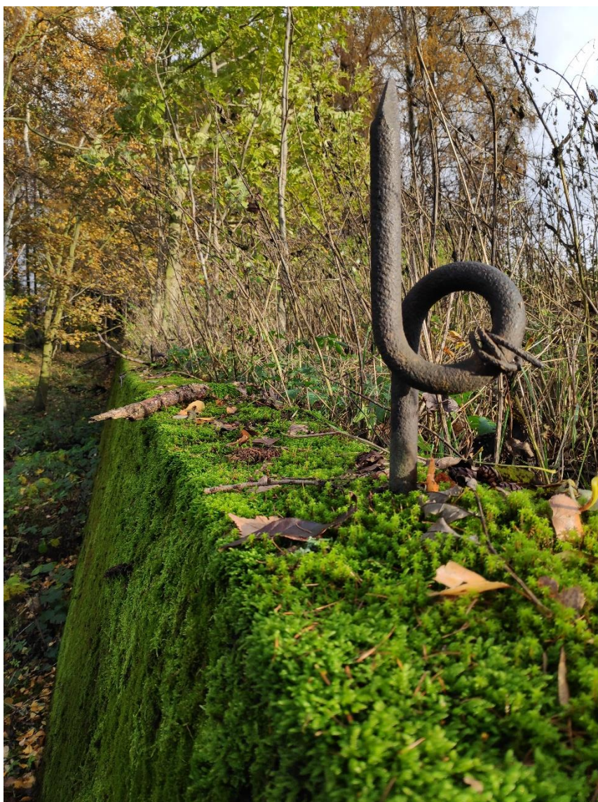
Obr. 42: Příkop proti útočné vozbě mezi K-Bg-S 13 a K-S 14.
