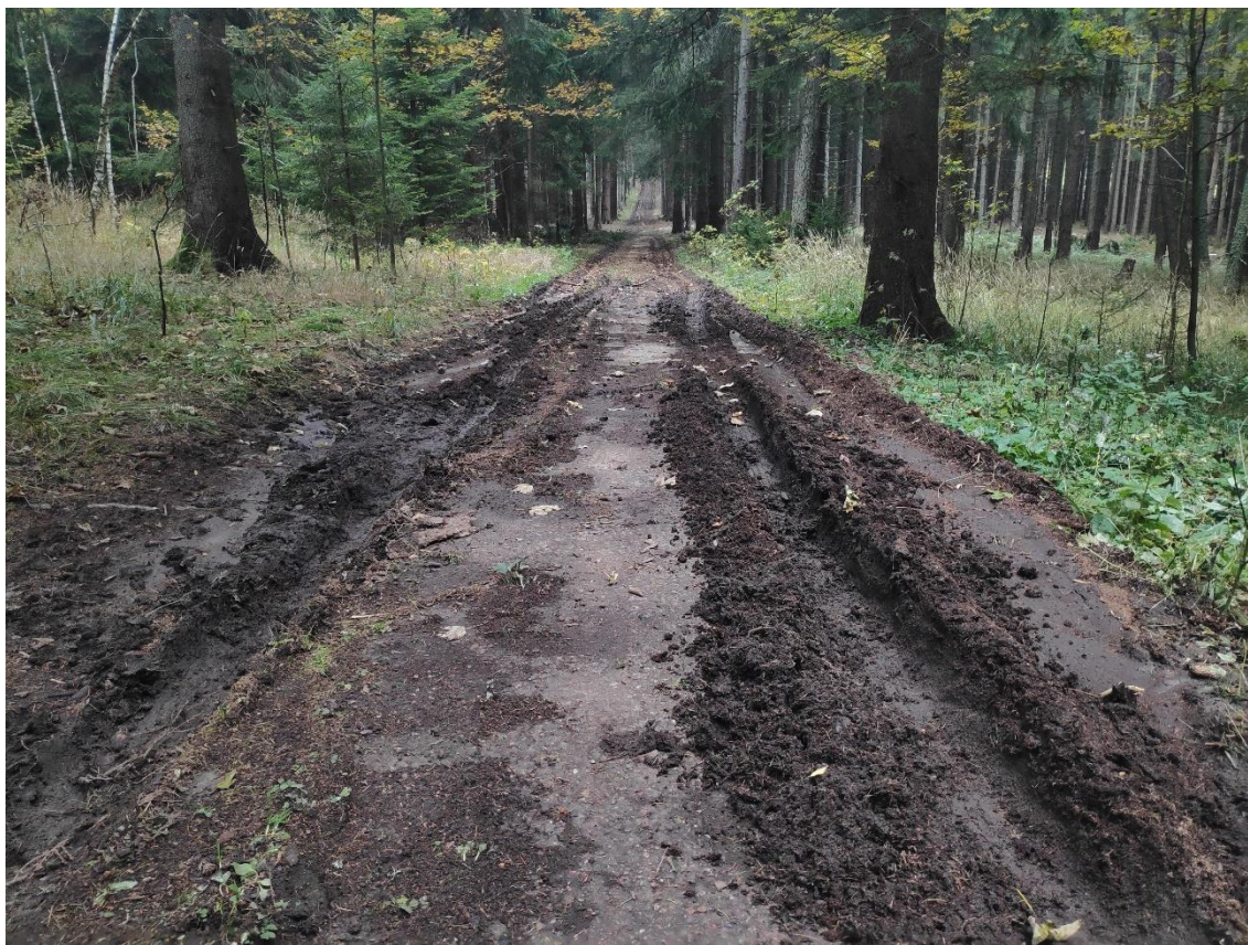
Obr. 36: Železobetonový práh mezi K-S 2 a plánovaným K-S 1, splývající s lesní cestou.
