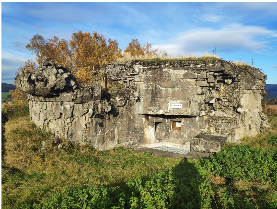
Obr. 20: Značně poškozený K-Bg-S13 s diamantovým příkopem překrytým mříží.
