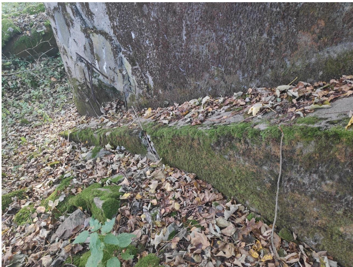
Obr. 13: Betonová rampa vedoucí na střechu objektu K-S 9.
