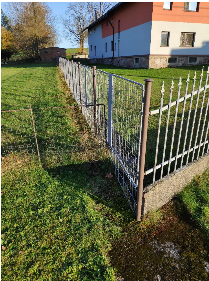
Obr. 49: Železobetonový práh, intervalová překážka mezi K-S 18 a K-S 19, procházející skrz obec Dolní Boříkovice.
