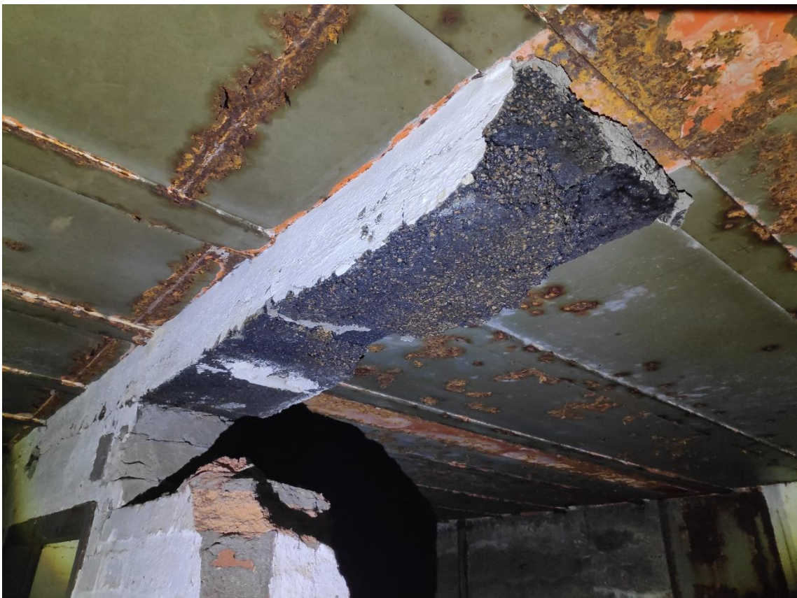
Obr. 9: Dochované korkové cihly uvnitř K-S 6.
