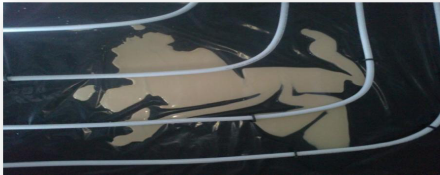
Obrázek č. 12: Počátek ukládání směsi topného potěru na separační vrstvě
