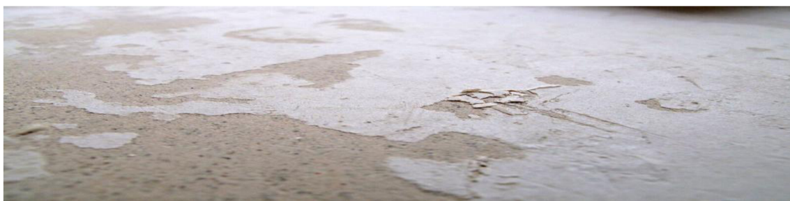
Obrázek č. 13: Nesoudržná vrstva šlemu vykrystalizovaná na povrchu potěru dodávaného firmou Cemex [24]
