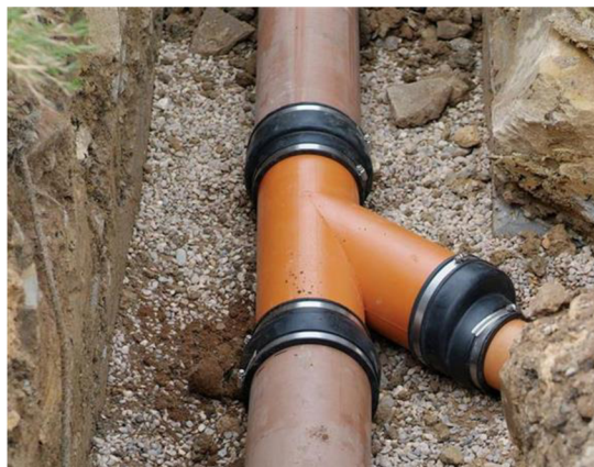
Obr. 3.5 Dodatečně vkládaná univerzální 45° odbočka [19]
