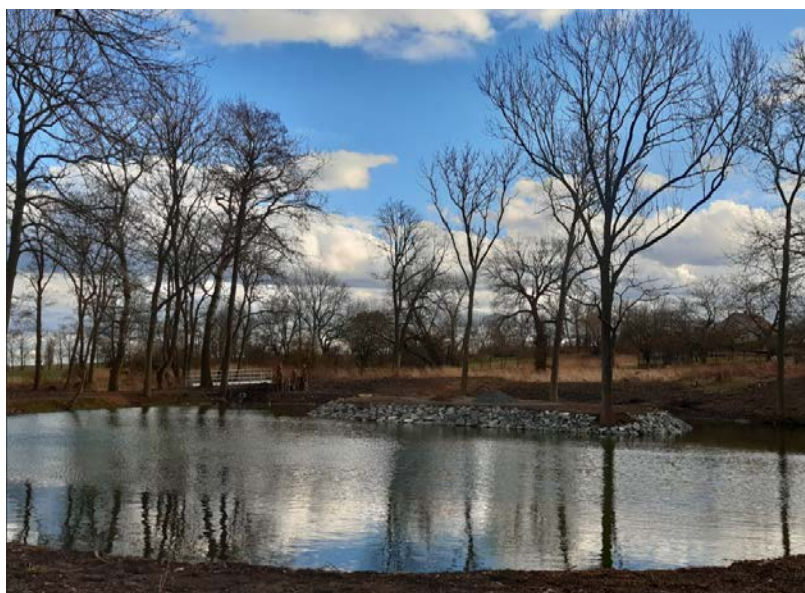
Obr. 10: Opevnění ostrůvku kamennou rovnaninou.
