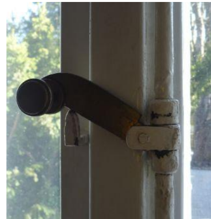
Bild Nr. 24: Detail des Fenstergriffes im „Poldihaus“
