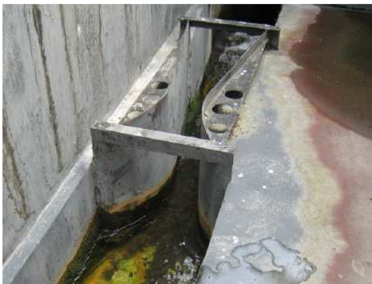
Obr. 6 Protiproudňí pohled na Venturiho ůlab, fotodokumentace LVV
