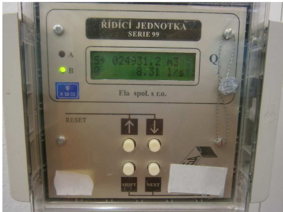
Obr. 20 Fotografie vyhodnocovací jednotky průtokoměru nad 3 \text{ l}\cdot\text{s}^{-1}
