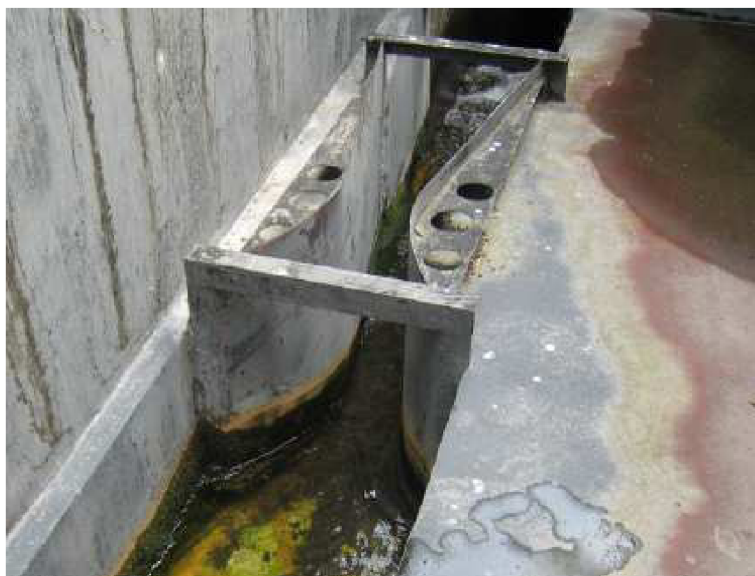
Obr. 6 Protiproudňí pohled na Venturiho ůlab, fotodokumentace LVV
