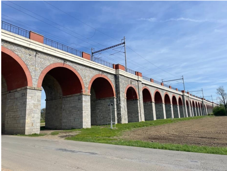
Obr. 20: Jezernický viadukt, foto: autor, říjen 2023
