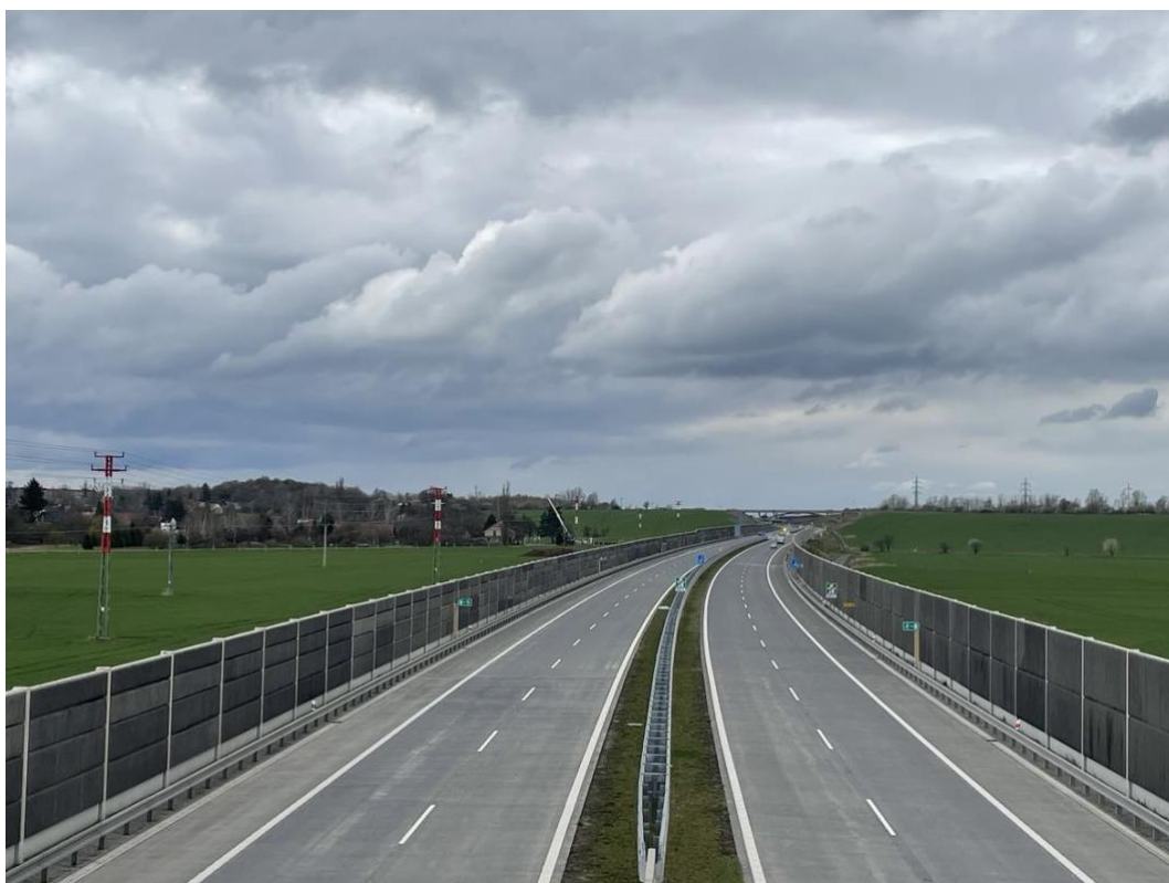
Obr. 18: Těleso dálnice D1 u obce Vinary, foto: autor, duben 2023
