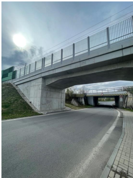
Obr. 19: Železniční mostní konstrukce u obce Lýsky, foto: autor, březen 2024
