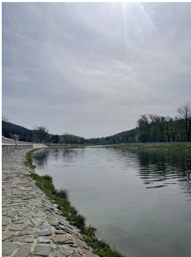
Obr. 13: Zákrut řeky Bečvy a povodňová ochrana ve městě Hranice, foto: auto, březen 2024
