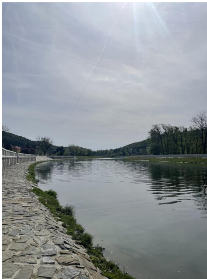
Obr. 13: Zákrut řeky Bečvy a povodňová ochrana ve městě Hranice, foto: auto, březen 2024
