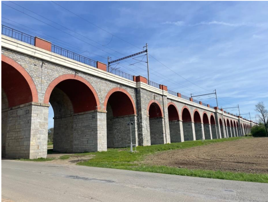
Obr. 20: Jezernický viadukt, foto: autor, říjen 2023
