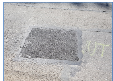
Obr. 44 až Obr. 49: Příprava a pokládka zkušební vysrávky
