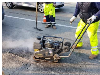
Obr. 44 až Obr. 49: Příprava a pokládka zkušební vysrávky
