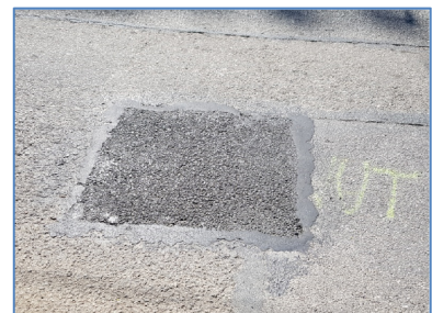
Obr. 44 až Obr. 49: Příprava a pokládka zkušební vysprávkování
