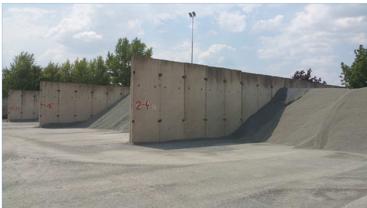
Obr. 11: Skladování jednotlivých frakcí kameniva na obalovně
