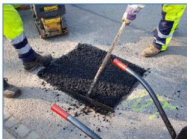
Obr. 44 až Obr. 49: Příprava a pokládka zkušební vysprávkování
