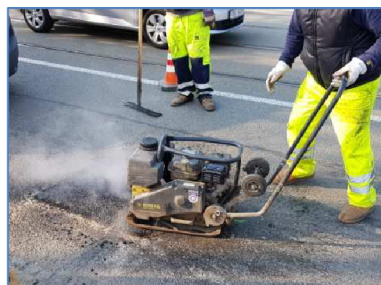
Obr. 44 až Obr. 49: Příprava a pokládka zkušební vysprávkování
