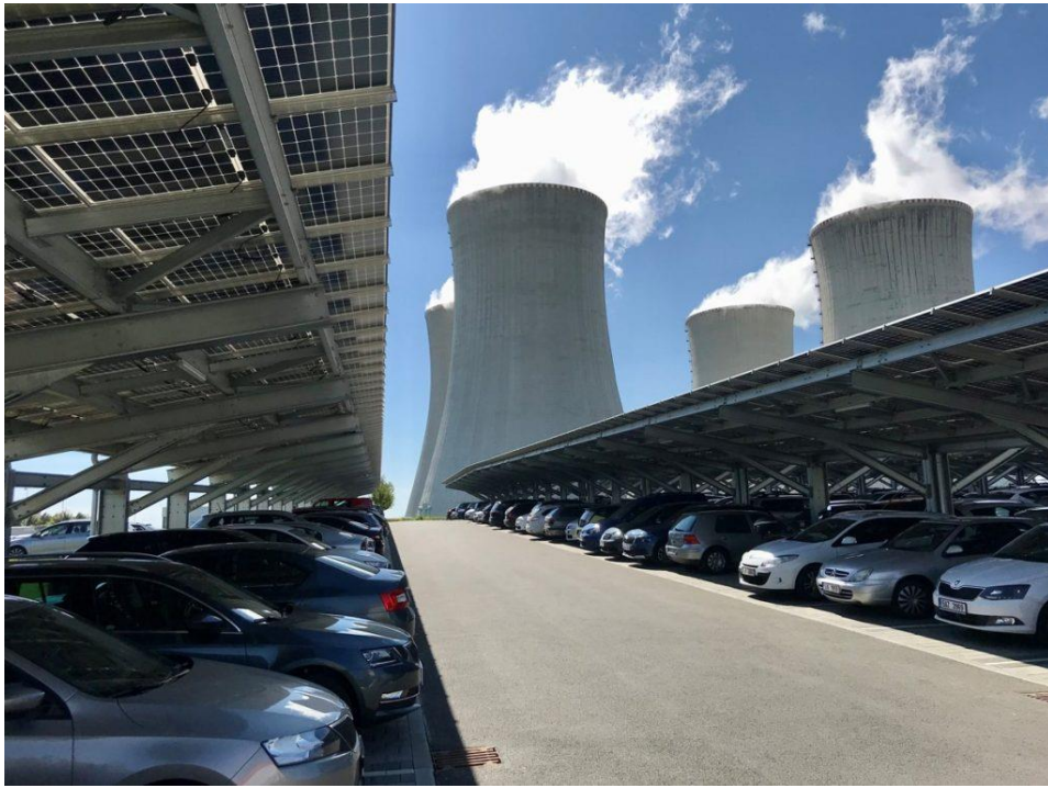
Obrázek 10.9 Solární parkoviště Dukovany [80]
