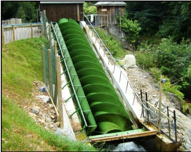
Obr. 6.6 – Šneková turbína na řece Dart (Ashburton, UK) od společnosti MannPower Zdroj: [22]
