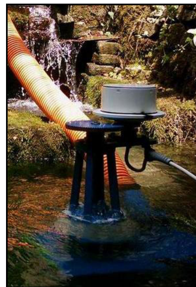
Obr. 6.10b – DVE 120 (po instalaci)
