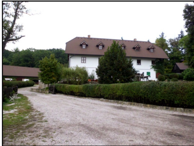
Obr. 5.1 – Ústřední budova mlýna po rekonstrukci
