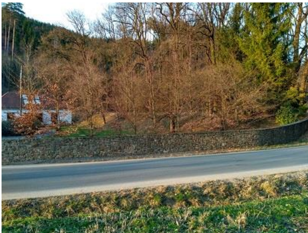
Obr. 41 Hráz na soukromém pozemku v obci Jaroměřice, (foto: Bártová, 2017)
