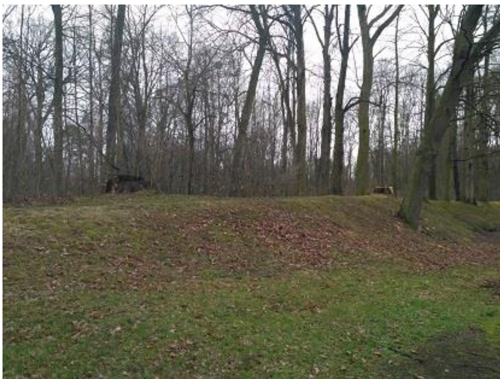
Obr. 30 Hráz v jezdeckém areálu v obci Žádlovice, (foto Bártová, 2017)
