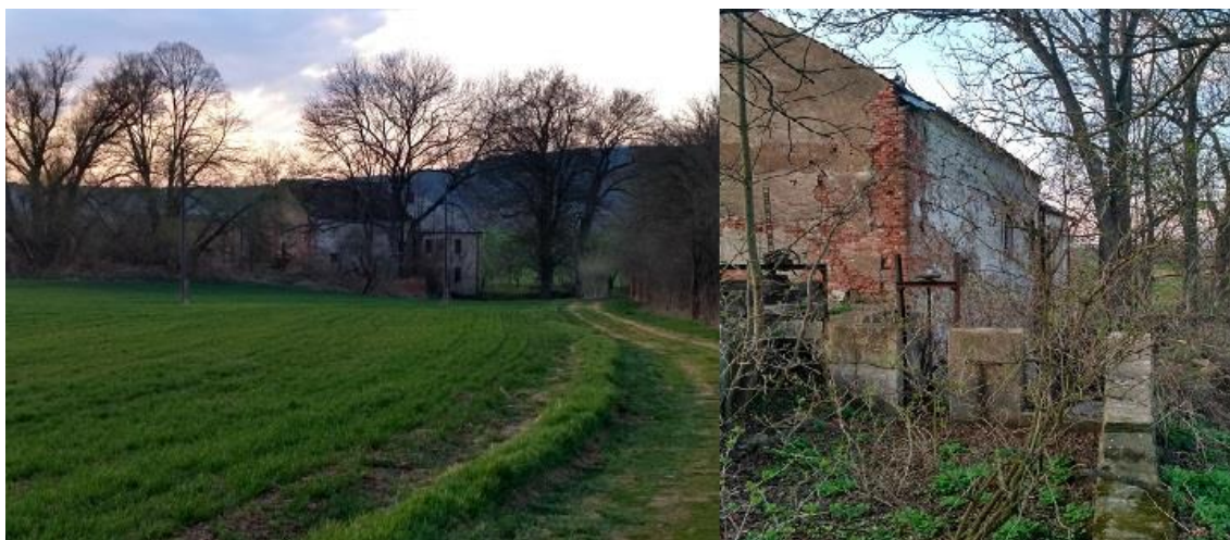
Obr. 27 Zaniklá hráz v místě Biskupického Mlýna, (foto Bártová, 2017)
