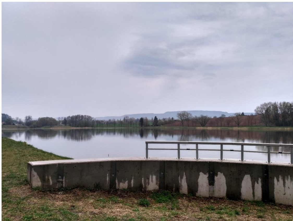
Obr. 3 Vodní nádrž Moravská Třebová, (foto: Klára Bártová, 2017)
