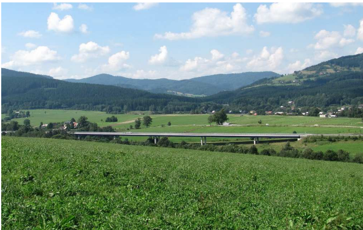
Migrační koridor Jablunkov z východu: estakáda (č. 11-193) z obou stran navazuje na zemědělské pozemky. Foto: Tomáš Krajča
