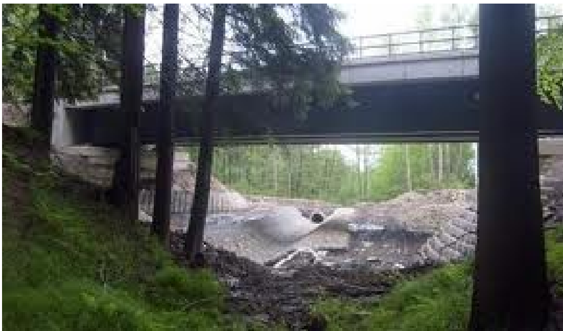
Jablunkov - nově budovaný podchod pod železnicí, který je dostatečný pro průchod velkých savců. Foto: Tomáš Krajča
