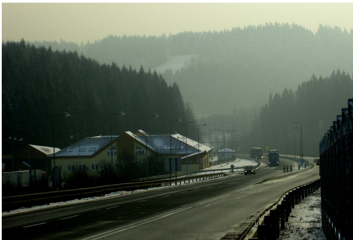
Koridor Celnice – chybí zde přechod pro zvěř. Foto: Tomáš Krajča
