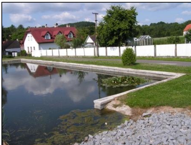
Obrázek 5.1: obec Nerestce - požární nádrž
