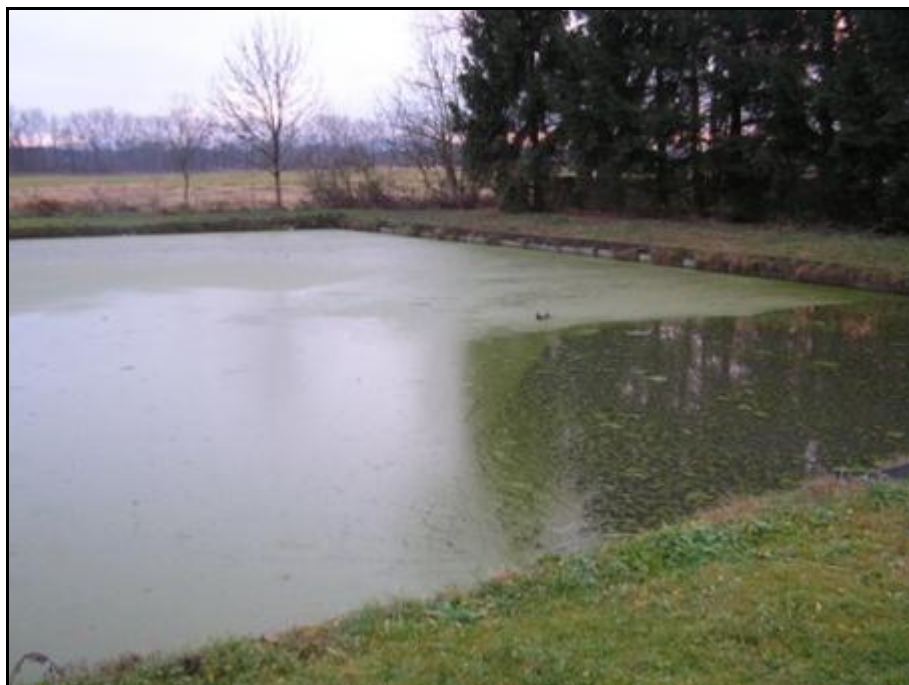
Obrázek 4.18: požární nádrž obce Kestřany
