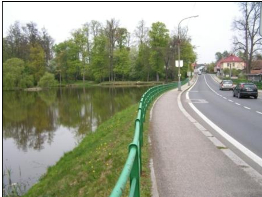
Obrázek 4.8: požární nádrž - Kostelák
