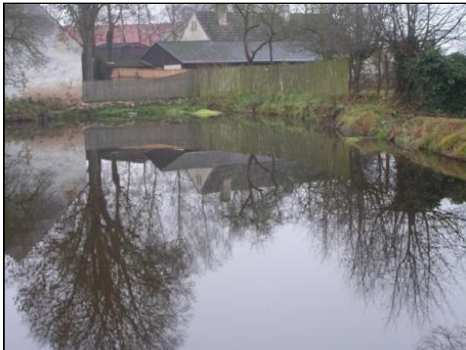
Obrázek 4.38: požární nádrž obce Podolí I.
