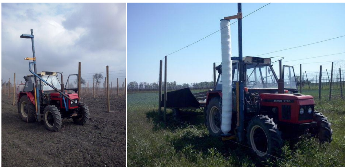
Obr. 1: Zapichování sloupů NK.
