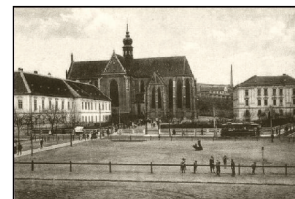
Pohled na kostel a Klášterní náměstí. (1909)
