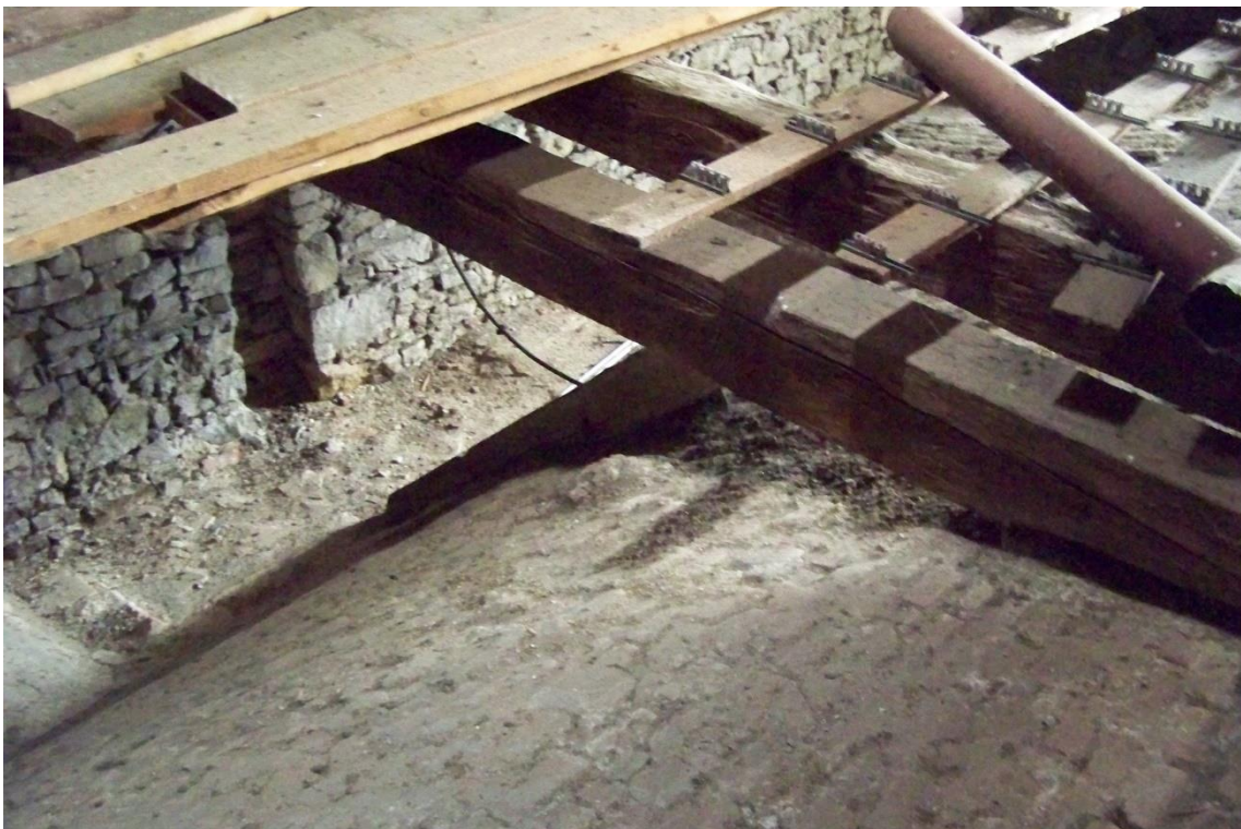
11. Bojkovice, kostel sv. Vavřince, 1651–1656, podkroví, detail zabezpečení klenby nad presbytářem, konstrukce z dřevěných táhel.
