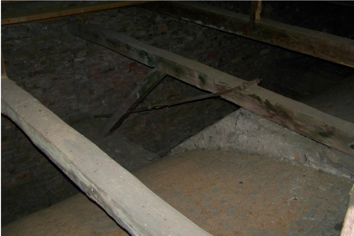
14. Bojkovice, kostel sv. Vavřince, 1651–1656, podkroví, detail krovu a soustavy táhel nad lodí kostela.
