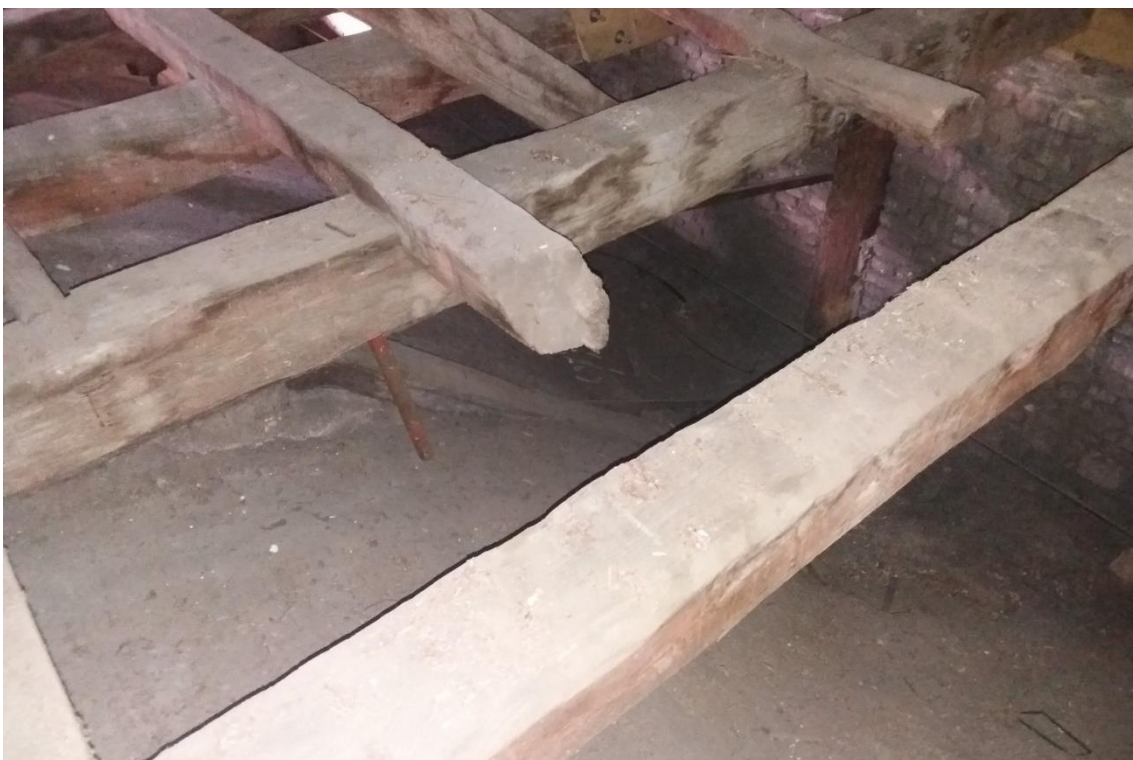
36. Brno, kostel sv. Josefa u kláštera františkánek, 1651–1653, rub klenby, detail konstrukce krovu a táhel.
