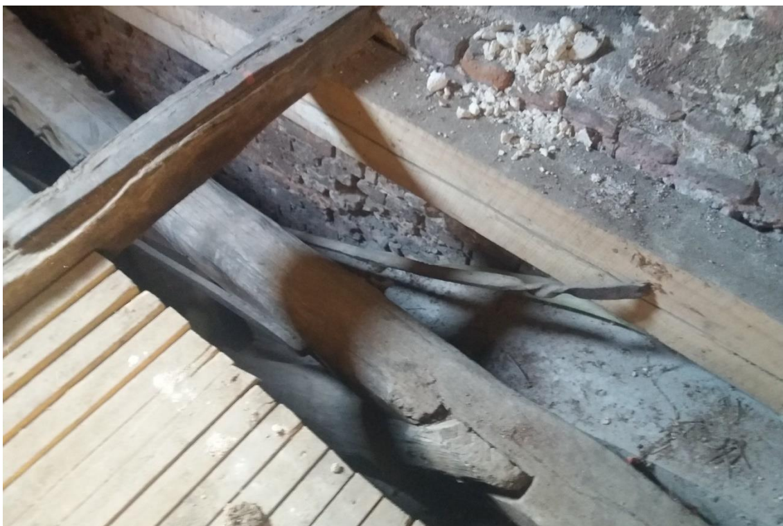
34. Brno, kostel sv. Josefa u kláštera františkánek, 1651–1653, detail krovu, uprostřed systém dřevěných a kovových táhel.
