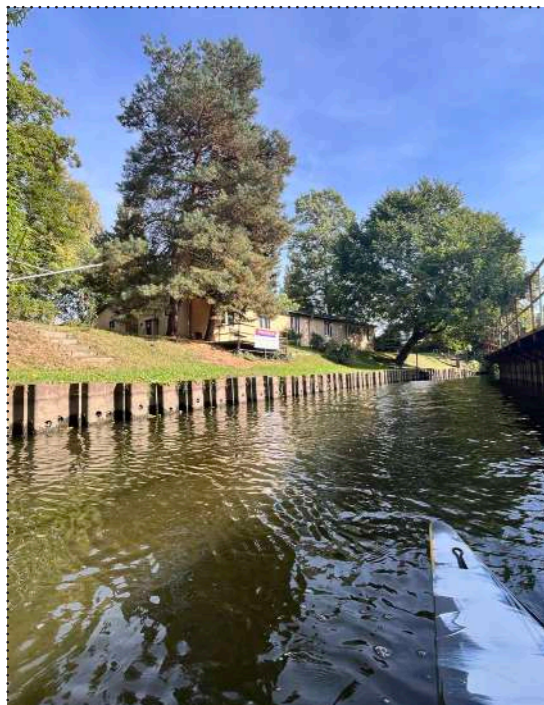
Obr. 89: L- Loděnice a úpravený břeh
