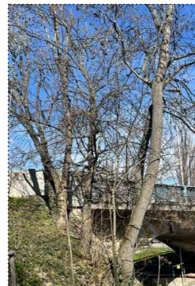
Obr. 59: Stromy (č. 20.–23.) u paty mostu
