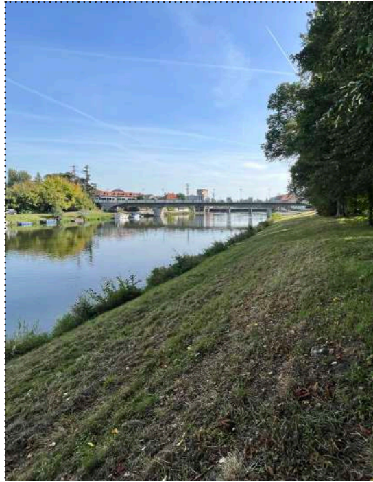
Obr. 85: I- Pohled na most přes řeku Labe
