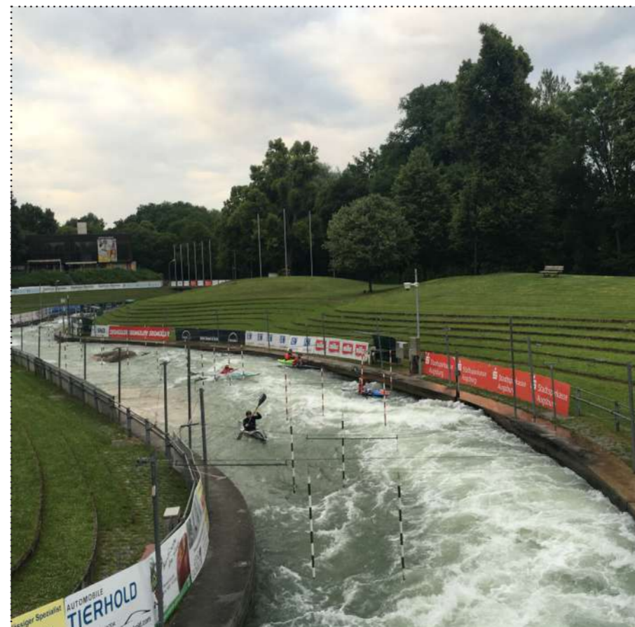
Obr.18: Pohled na úpravy břehů kanálu
