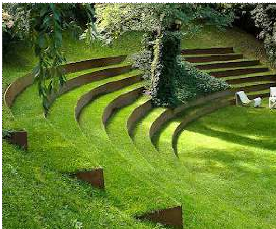
Obr.114: Cortenové stupně
