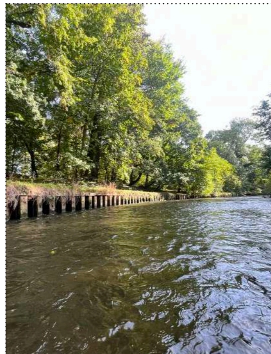
Obr. 91: N- Technicky upravený břeh
