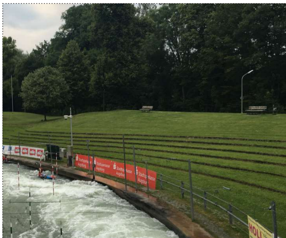
Obr.125: Cortenové stupně
