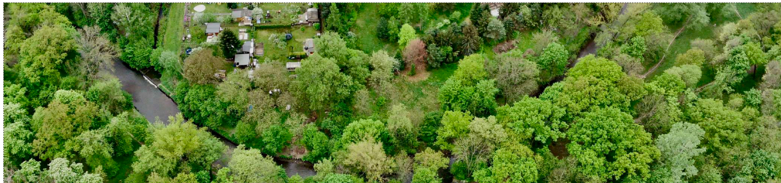
Obr.72: Pohled na odtokový kanál - přírodě blízká část
