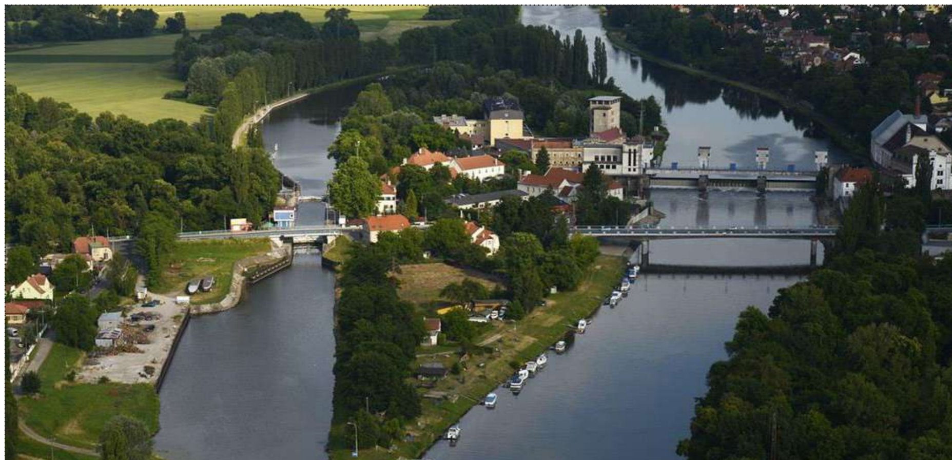
Obr.1: Pohled na zdymadlo a jez v Brandýse nad Labem-Staré Boleslavi
