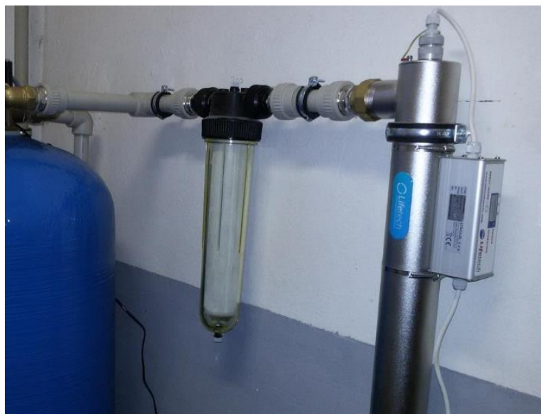
Obr. 5 UV lampa pro dezinfekci vody [20]
