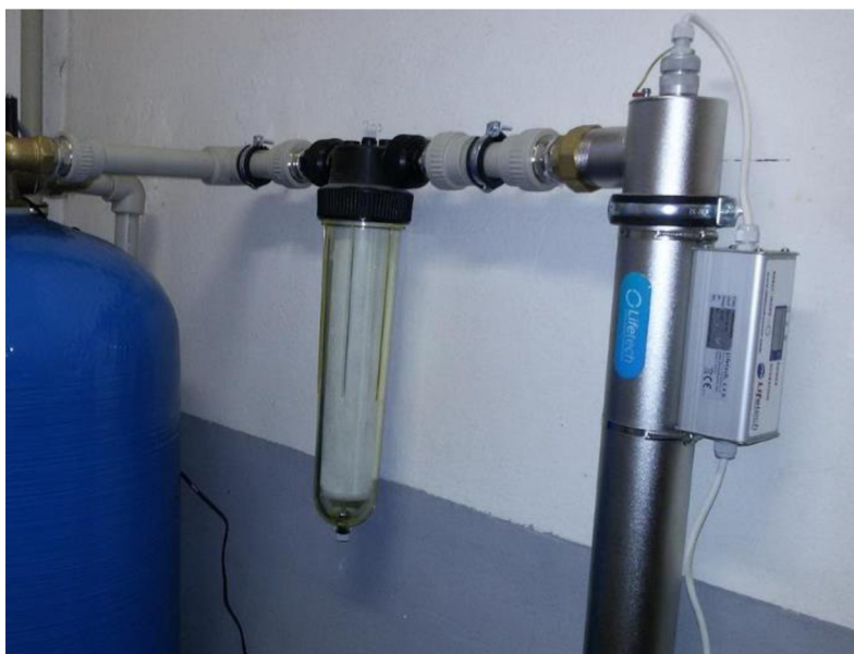
Obr. 5 UV lampa pro dezinfekci vody [20]
