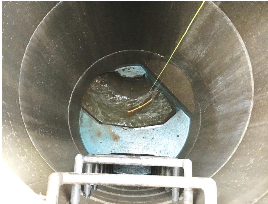
Obr. 4.9 Zavěšení gelového plátu v šachtě
