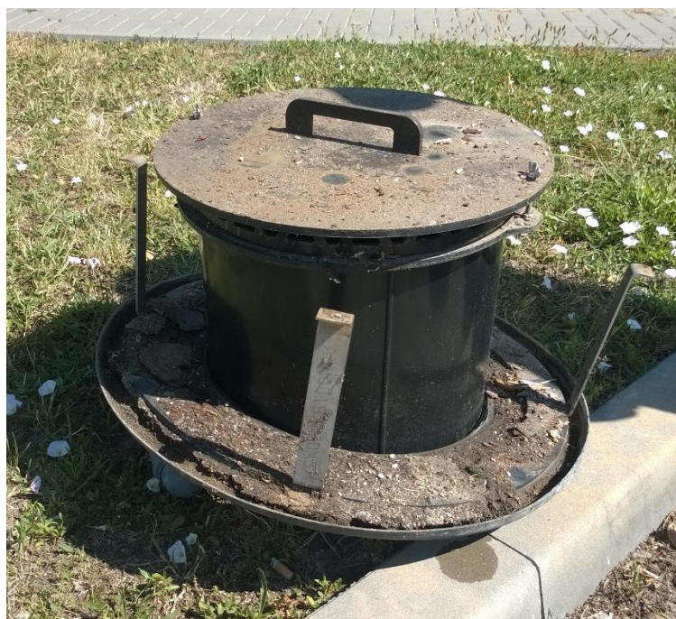
Obr. 4.4 Vyjmutý filtr, perforovaný válec pod víkem
