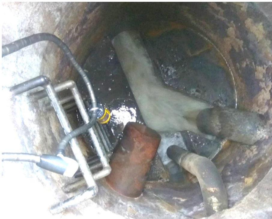
Obr. 4.6 Pohled do předávací šachty
