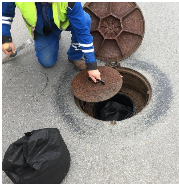
Obr. 2.10 Příklad šachtového filtru
