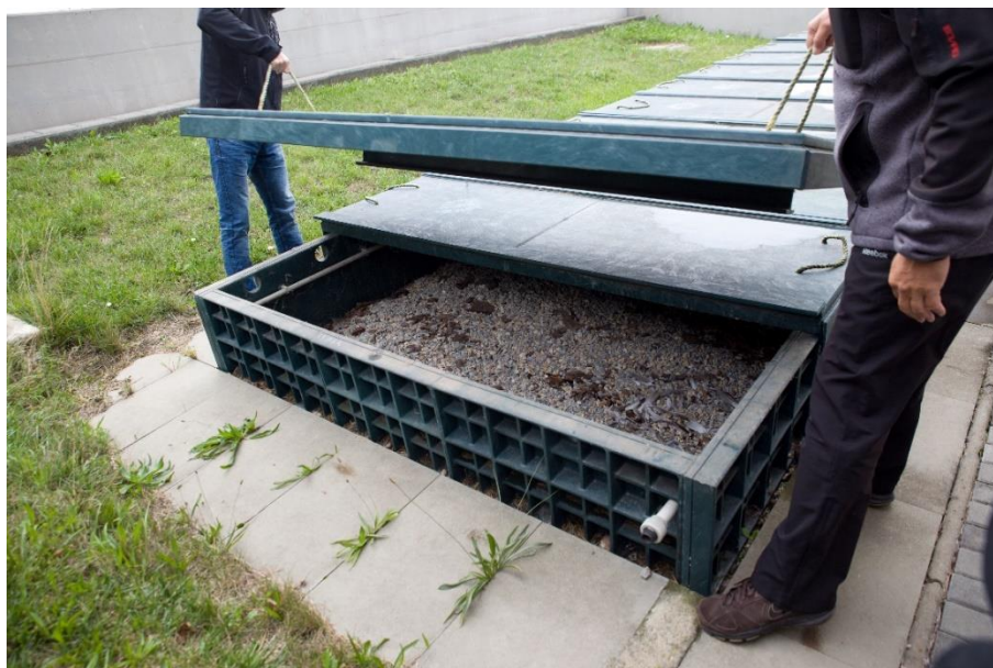
Obr. 2.8 Příklad biologického filtru
