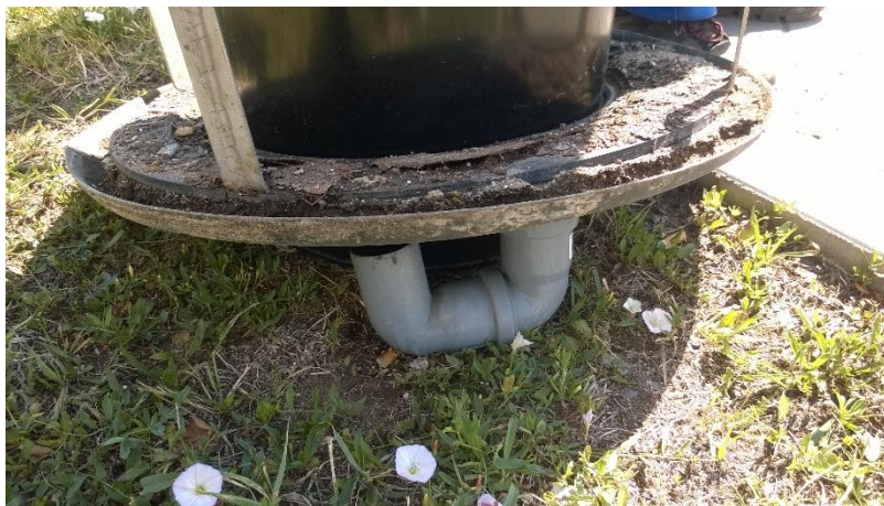
Obr. 2.12 Sifon na kanalizačním filtru
