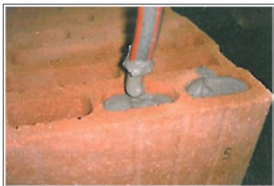
Obr. č. 26 - Vyplňování dutin izolačním materiálem na silikátové bázi, součinitel tepelné vodivosti \lambda \leq 0,045 \text{ W/(m}\cdot\text{K)} [49]
