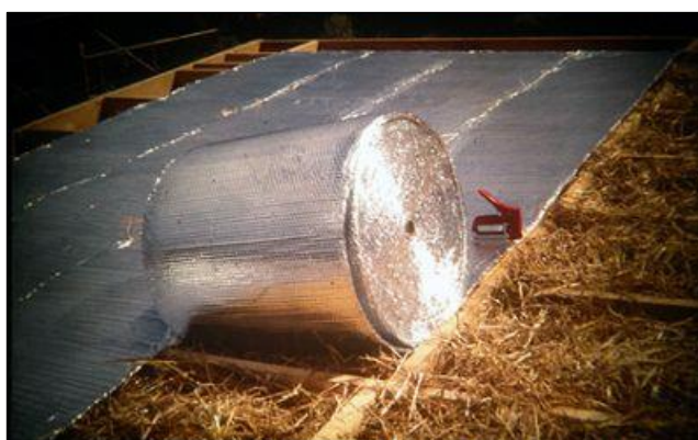
Obr. č. 24 – Slaměná izolace šikmé střechy [37]
