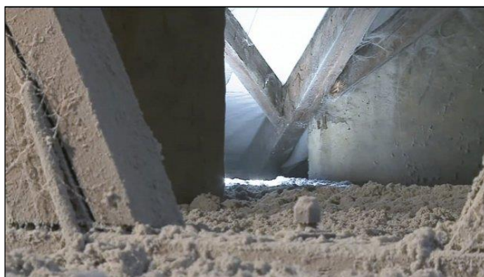
Obr. č. 22 - Celulózná tepelná izolace je aplikována foukáním, lze jí vyplnit jakékoli, i obtížně dostupné dutiny (foto CIUR) [8]
