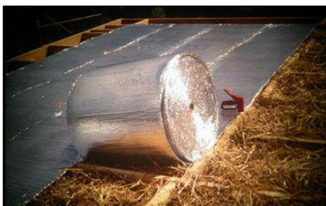
Obr. č. 24 – Slaměná izolace šikmé střechy [37]
