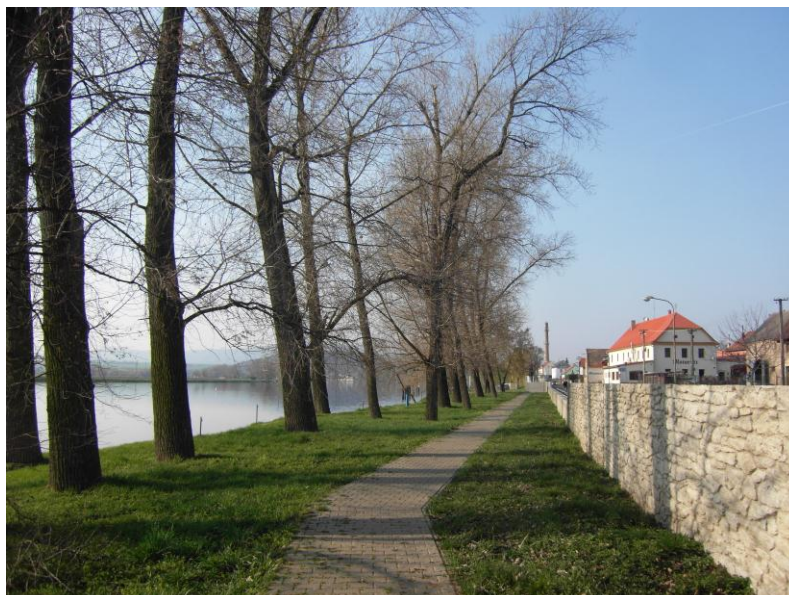
Obrázek č. 7, Protipovodňová stěna v obci (vlastní archiv)
