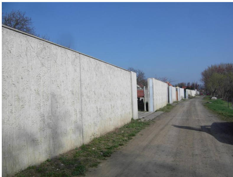
Obrázek č. 6, Protipovodňová stěna v těsné blízkosti řeky (vlastní archiv)
