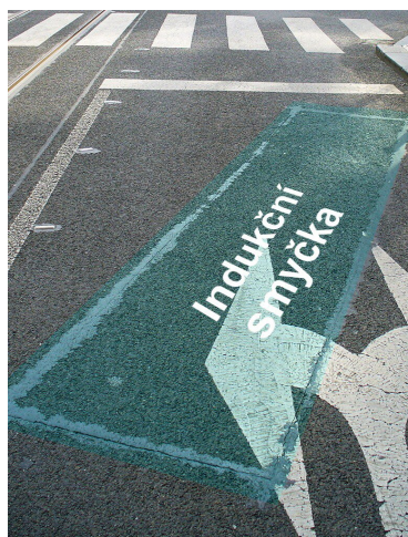
Obrázek 2.7: Smyčka v silnici (převzato z https://pid.cz/o-systemu/preference/ )
