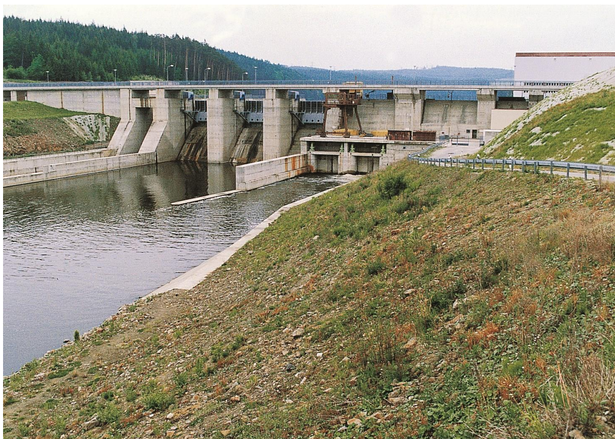
Obr. 1.2 MVE Hněvkovice o výkonu 9,6MW [4]
