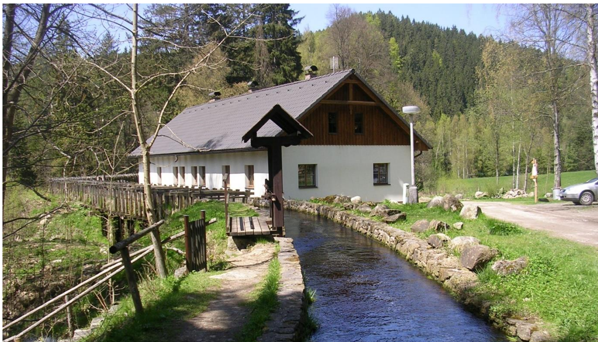
Obr. 1.3 MVE Čeňkova pila o výkonu 96kW [5]
