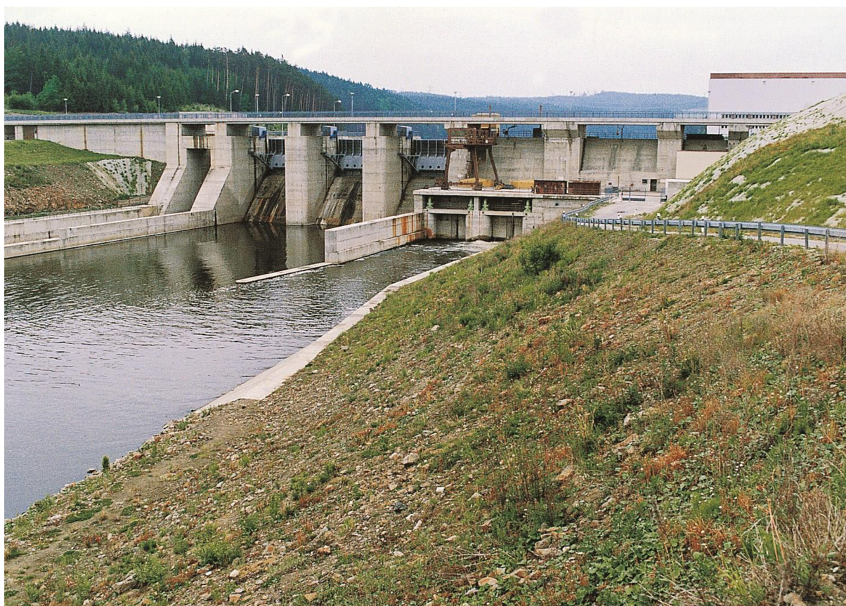
Obr. 1.2 MVE Hněvkovice o výkonu 9,6MW [4]
