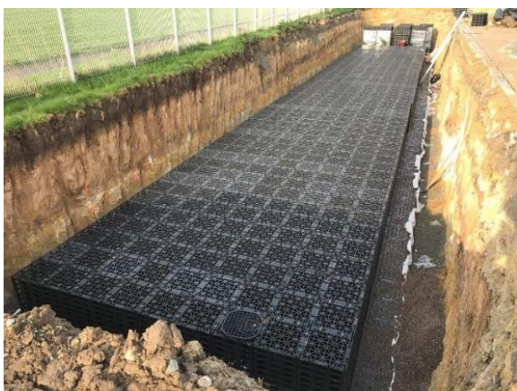
Obrázek 6: Vsakovací galerie z vsakovacích boxů (tzb-info.cz)
