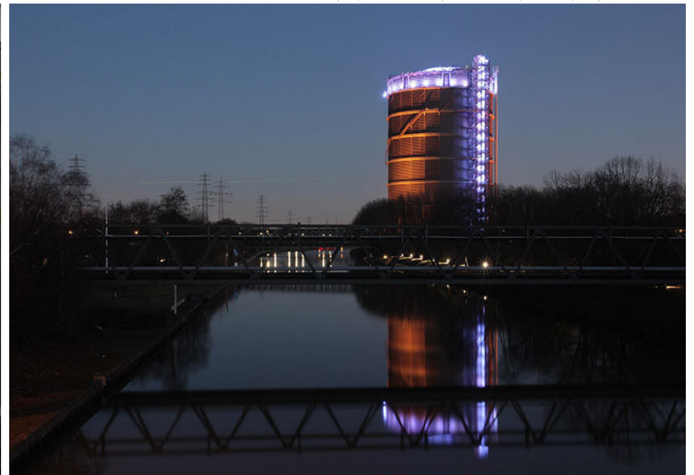
Obr. č. 12, zdroj: http://industriekultur-ob.de/oberhausen-gasometer/
