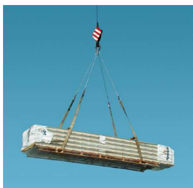
Obr. 11: Přeprava svazku autojeřábem
