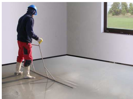
Obr. 21: Rovnání potěru nivelační hrazdou
