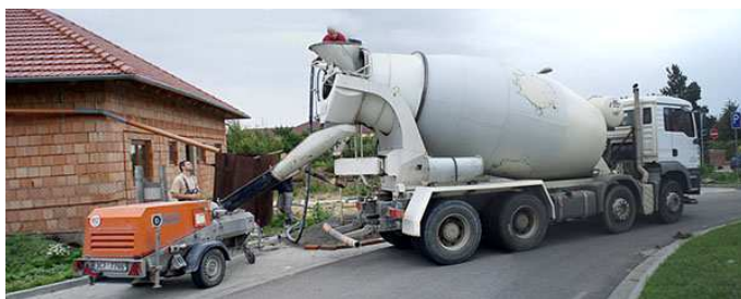
Obr. 22: Čerpání anhydritové směsi
