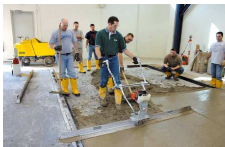
Obr. 19: Vibrování betonu vibrační lištou
