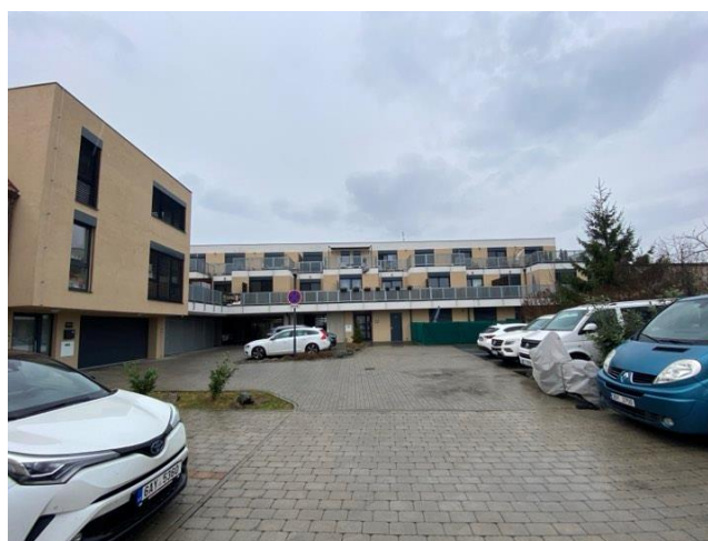
Obr. 20: Bytová jednotka, Líbeznice, 11. 2. 2024
