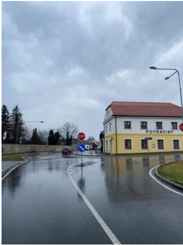
Obr. 22: Křižovatka ulic Mělnická a Zdibská, Líbeznice, 11. 2. 2024
