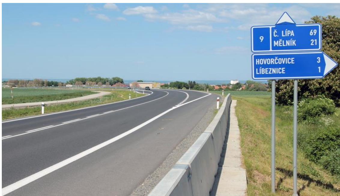
Obr. 7: Obchvat kolem obce Líbeznice, 2012 (stavbaroku.cz)
