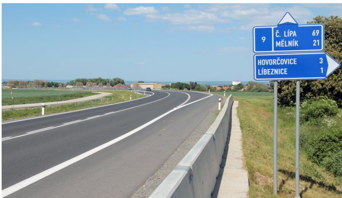
Obr. 7: Obchvat kolem obce Líbeznice, 2012 (stavbaroku.cz)
