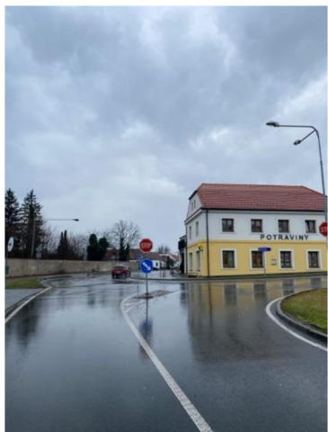
Obr. 22: Křižovatka ulic Mělnická a Zdibská, Líbeznice, 11. 2. 2024
