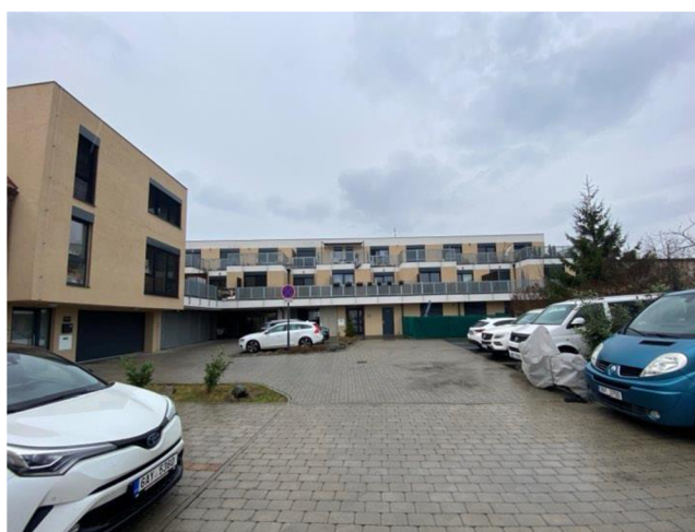
Obr. 20: Bytová jednotka, Líbeznice, 11. 2. 2024
