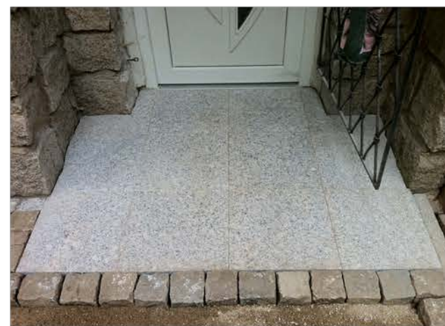
Obr. 75: Žulová dlažba – pokládka
