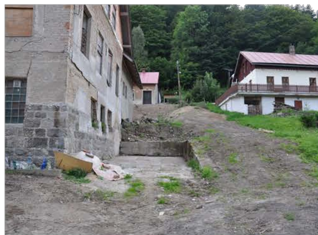
Obr. 35: Betonová monolitická zeď stání pro auta
