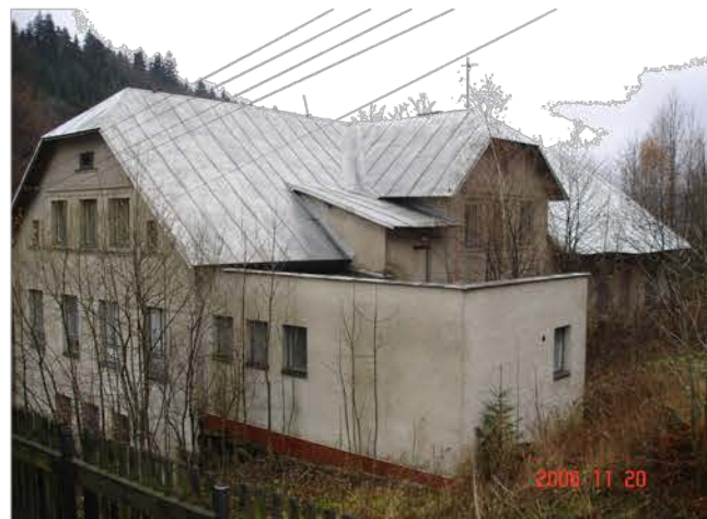
Obr. 27: Severní strana s přístavbou WC a sprch
