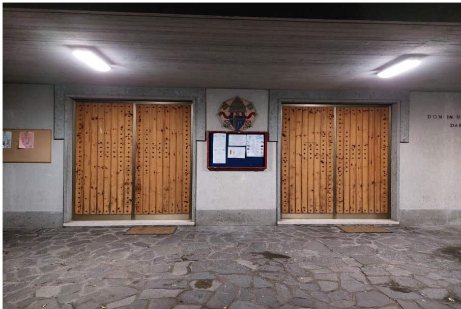
Obr. 24 Průčelí kostela svatých Chrysantha a Darii v Římě 162
