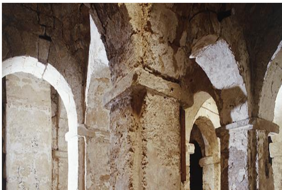
Obr. 14 Pohled na část krypty zasvěcené svatým Chrysanthovi a Darie v italské obci Oria 152
