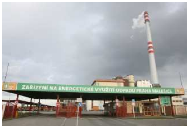
Foto č. 4: Spalovna nebezpečných odpadů v Praze – Malešicích (zdroj:ekolist.cz)
