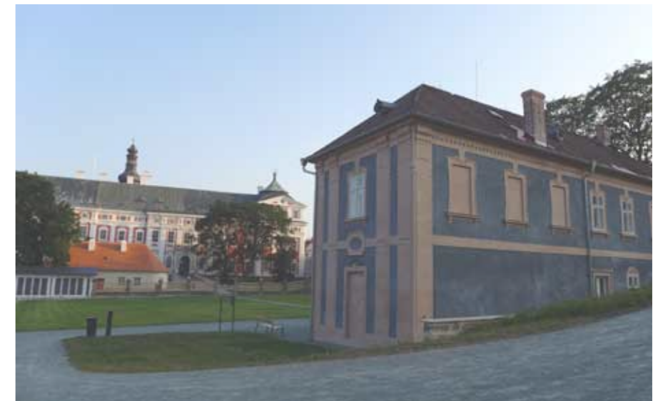
obr. 1. zrekonstruované fasády domku
