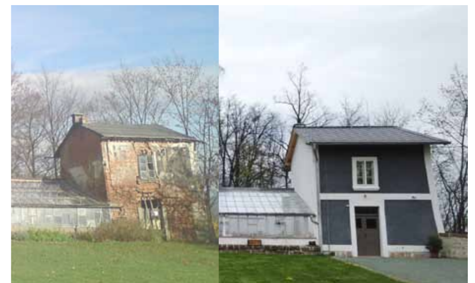
obr. 3. skleník stav před a po rekonstrukci
