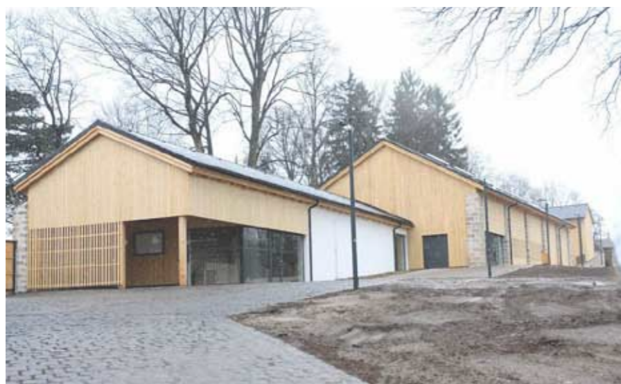
obr. 5. nově postavené hospodářské budovy
