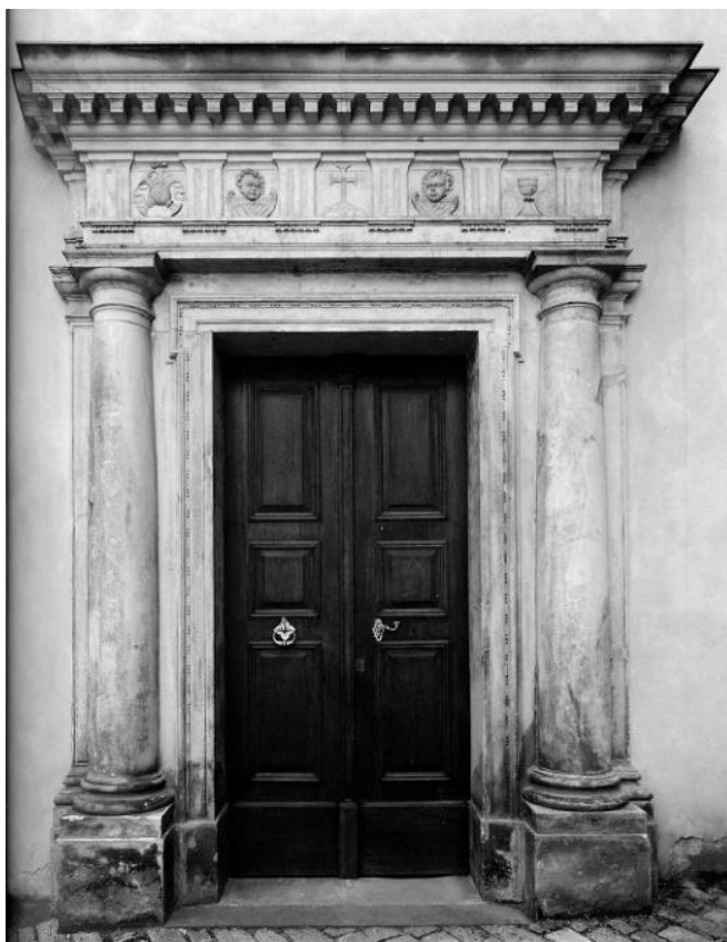
[14] Vstupní portál kaple Všech svatých na Pražském hradě, po přestavbě v 70. letech 16. století pod vedením Ulrica Aostallise
