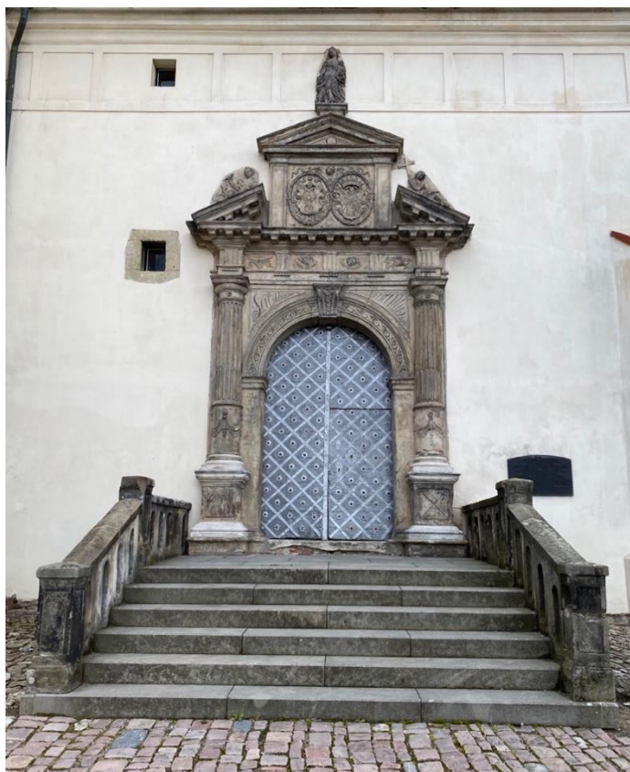
[21] Kostel Povýšení sv. Kříže, Litomyšl, 1605, západní průčelí, hlavní portál dnešní stav.
