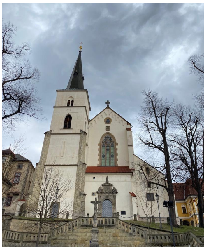
[17] Kostel Povýšení sv. Kříže, Litomyšl, polovina 14. století, západní průčelí, dnešní stav.
