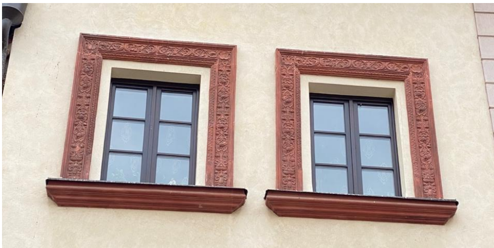
[73] Renesanční ostění po roce 1538, Pernštýnská ulice čp. 13 Pardubice.
