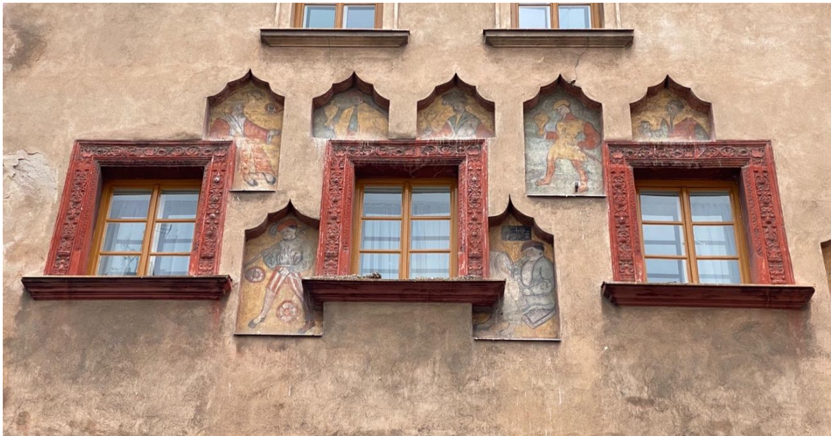
[71] Renesanční ostění po roce 1538, Pernštýnská ulice čp. 11 Pardubice.
