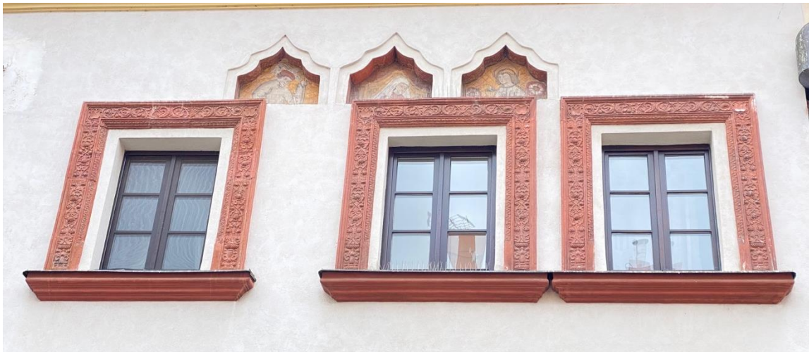
[72] Renesanční ostění po roce 1538, Pernštýnská ulice čp. 12 Pardubice.
