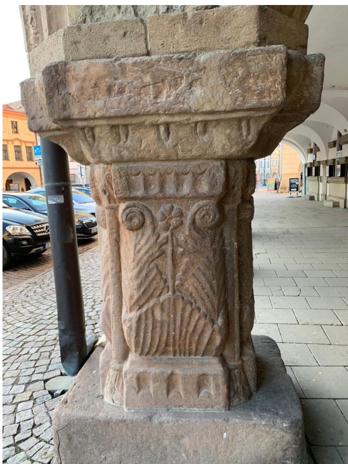
[42] Dům U Rytířů, levý boční pilíř.
