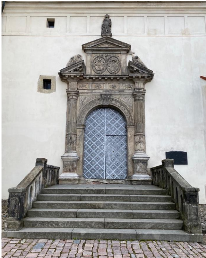
[21] Kostel Povýšení sv. Kříže, Litomyšl, 1605, západní průčelí, hlavní portál, dnešní stav
