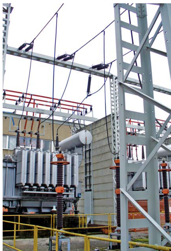
Obr. 8-1 Konštrukcia obmedzovačov PEXLIM R a HDA-MA [2], [17].
