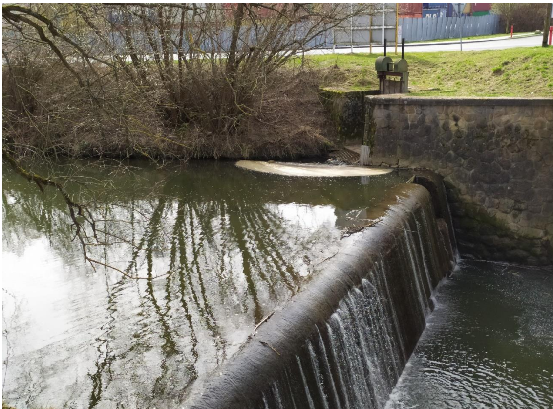
Příloha 9: Jez a stavidlo k MVE Želechovice nad Dřevnicí (Gabrhelík, 2023)
