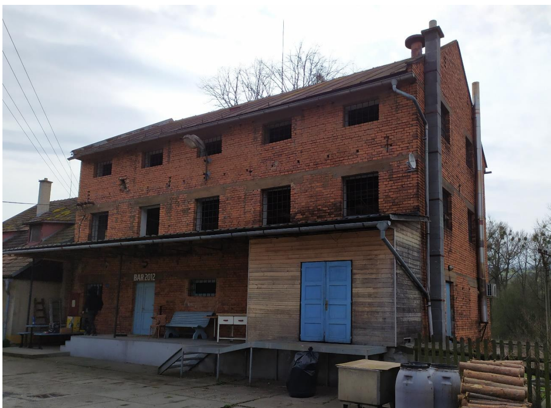
Příloha 28: Budova Nedbálkova mlýna čp. 128 v Zádveřicích (Gabrhelík, 2023)
