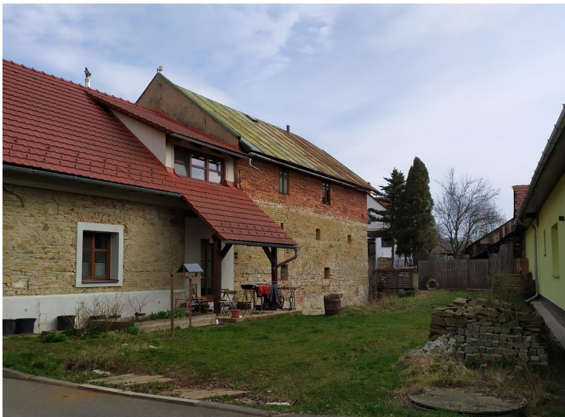
Příloha 27: Budova Jaškova mlýna čp. 57 v Zádveřicích (Gabrhelík, 2023)
