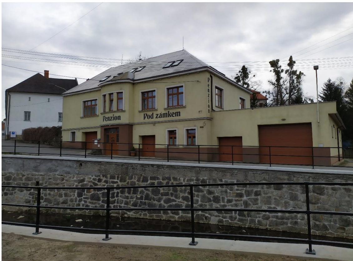
Příloha 31: Budova Faitova mlýna čp. 87 ve Vizovicích (Gabrhelík, 2023)
