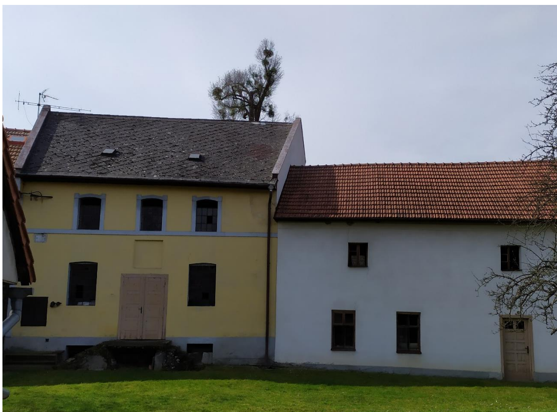
Příloha 8: Budova Polepilova mlýna čp. 21 v Želechovicích nad Dřevnicí (Gabrhelík, 2023)
