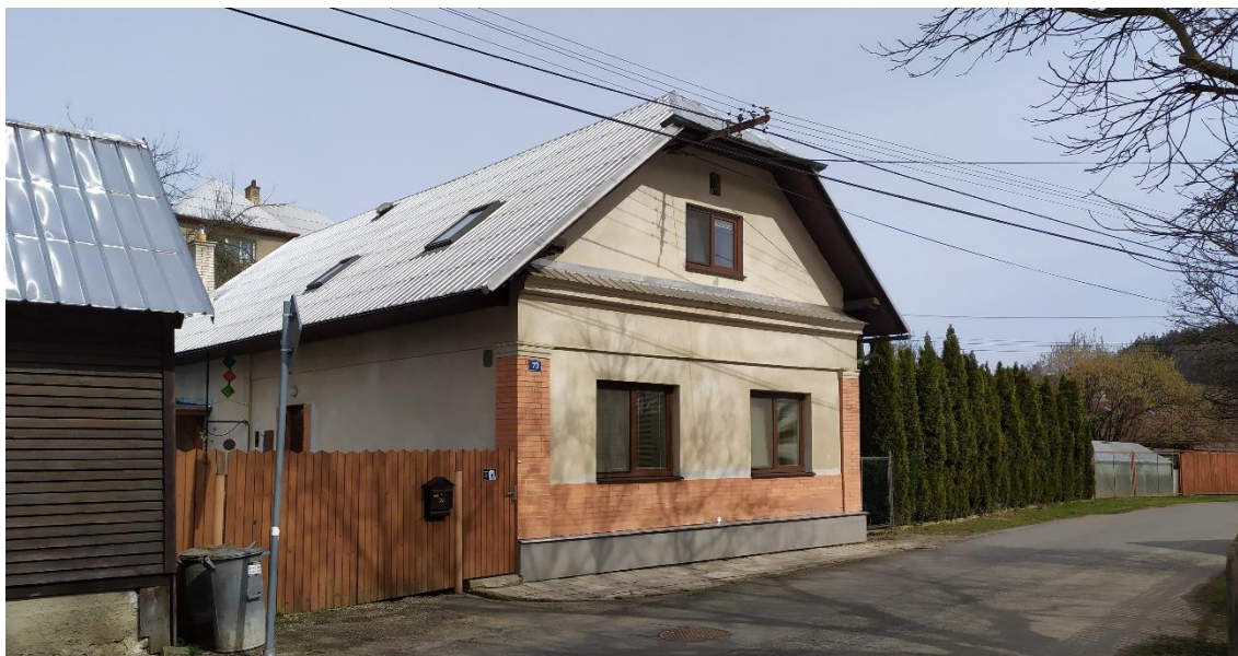
Obr. 27: Budova Horního mlýna čp. 73 ve Vlčkově (Gabrhelík, 2023)
