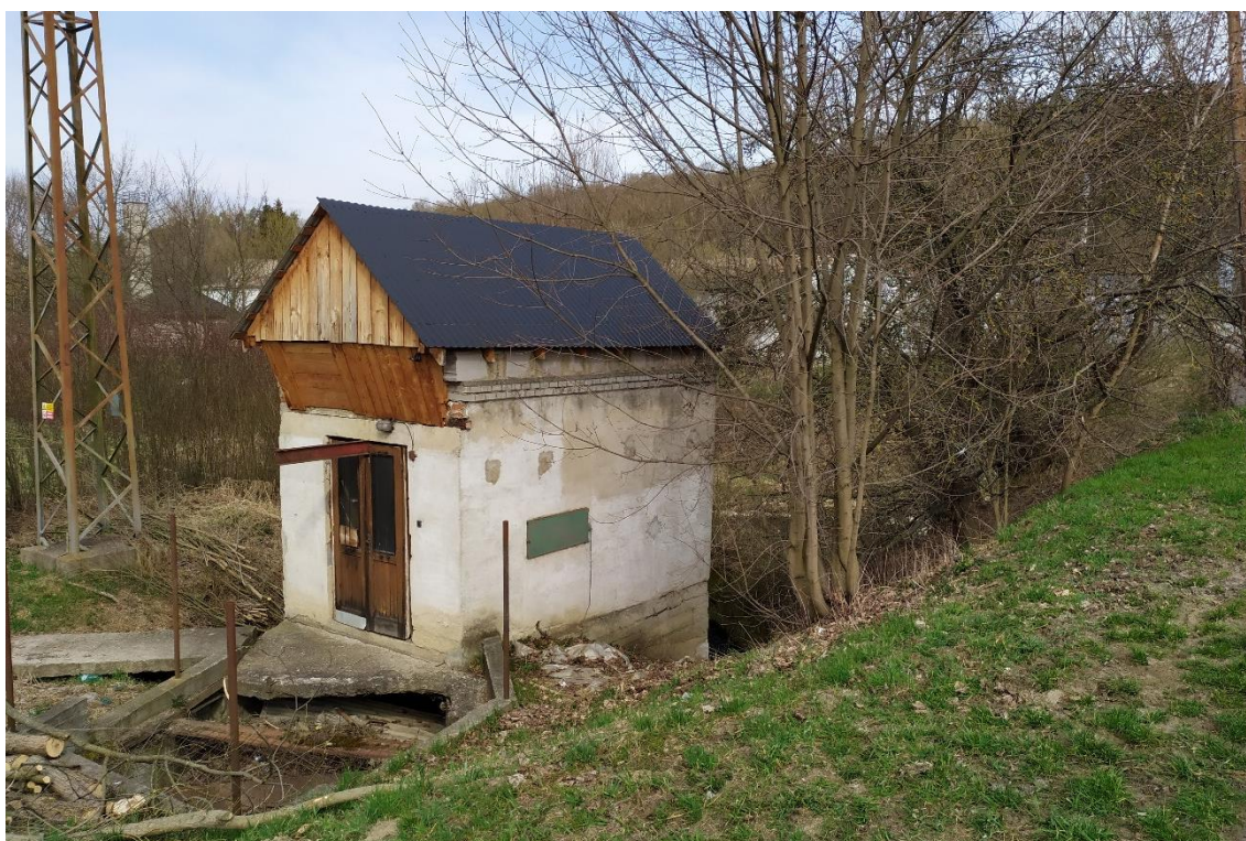
Obr. 11: Objekt MVE Želechovice nad Dřevnicí (Gabrhelík, 2023)
