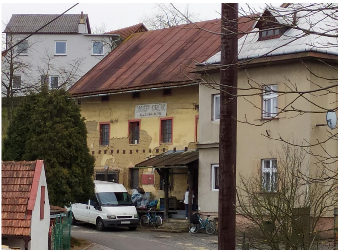
Příloha 32: Budova Kopanického mlýna čp. 301 ve Vizovicích (Gabrhelík, 2023)
