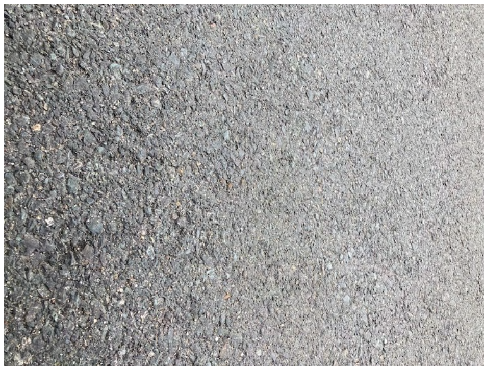
Obrázek č. 32 – Povrch vozovky (měřítko 1:10 cm)
