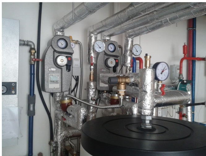
Obr. 3.3 Osazení čerpadlových skupin
