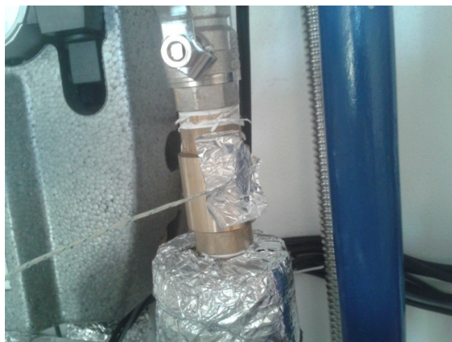
Obr. 3.6 Způsob připevnění termočlánků
