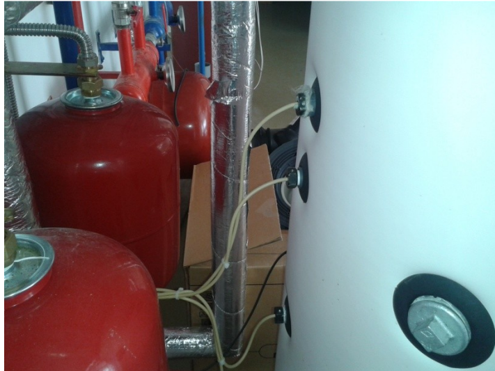
Obr. 3.4 Umístění či teplotních čidel v zásobníku
