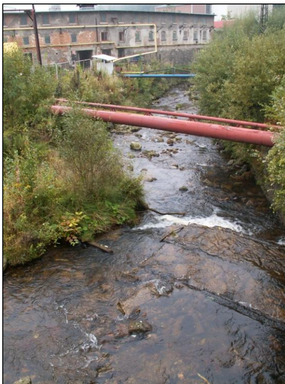
Obrázek č. 6: Pevný kamenný jez v říčním kilometru 1,512
