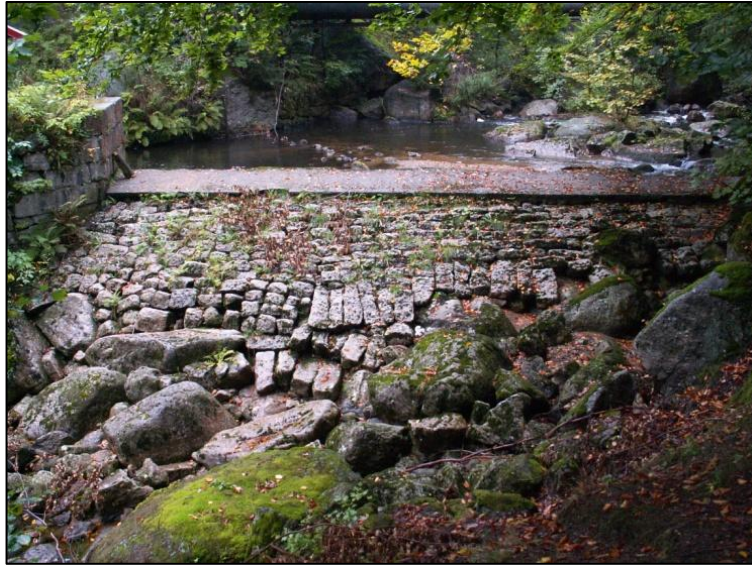
Obrázek č. 9: Kamenný jez s betonovou přelivnou plochou v říčním kilometru 2,238
