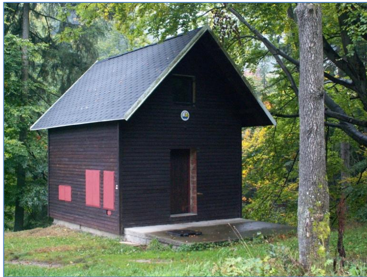
Obrázek č. 13: Strojovna malé vodní elektrárny Desná III
