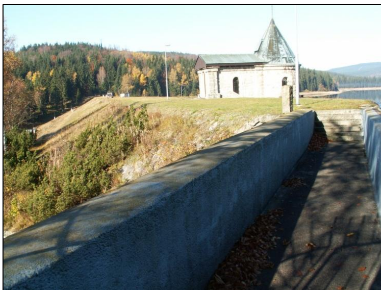
Obrázek č. 11: Hráz vodní nádrže Souš
