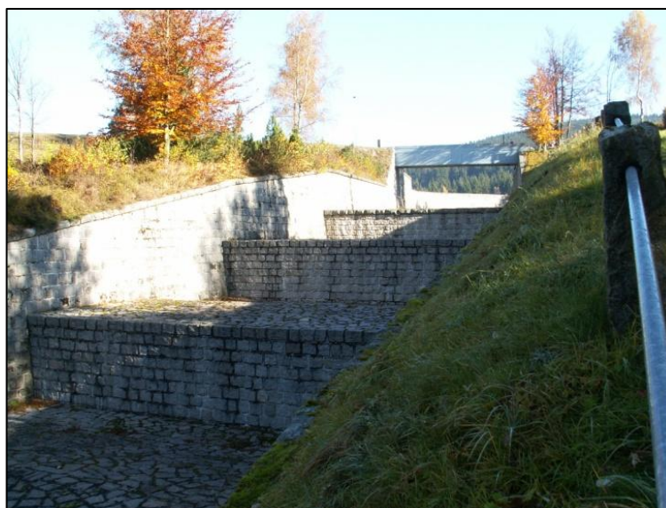
Obrázek č. 14: Boční kaskádová přepust' na vodní nádrži Souš
